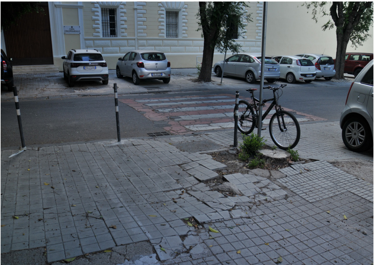
Foto n. 32 - Degrado pavimentazione
