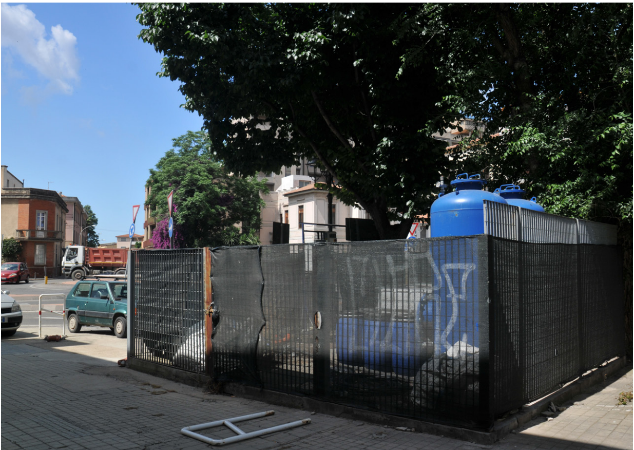
Foto n. 28 - Impianto di depurazione acque
