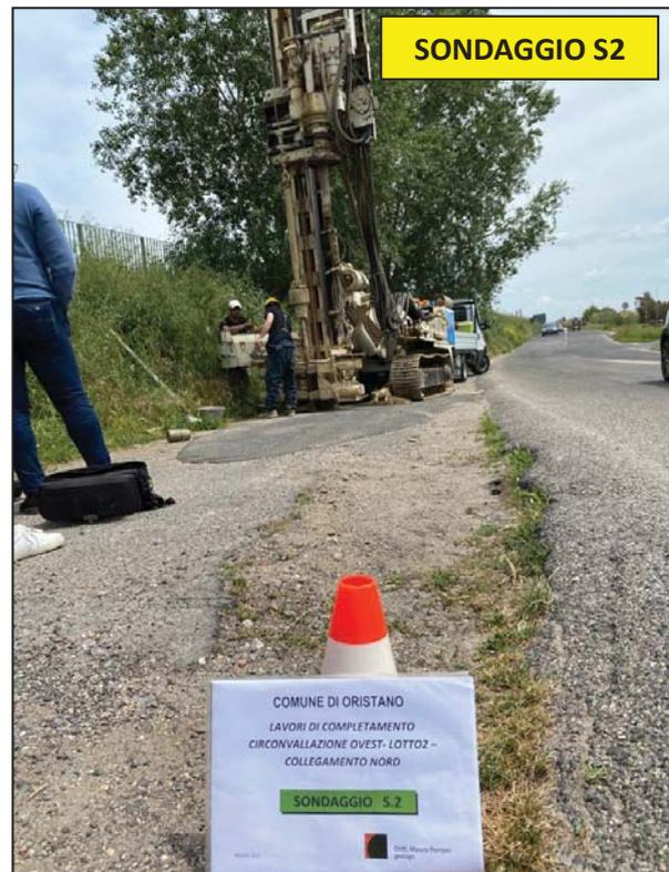
FIGURA 2.3 – Posizionamento dei sondaggi a carotaggio continuo.
