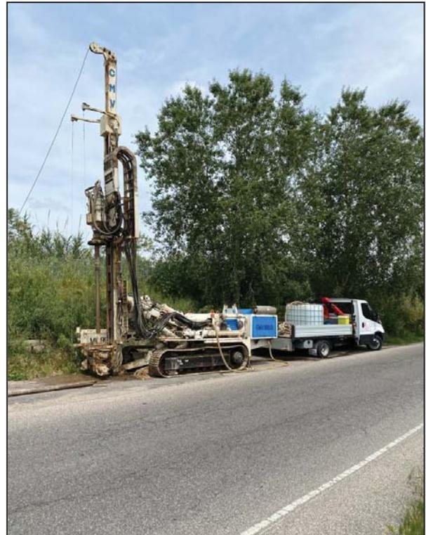
FOTO 2.7 e 2.8 – Dotazioni tecniche dei sondaggi a carotaggio continuo.
