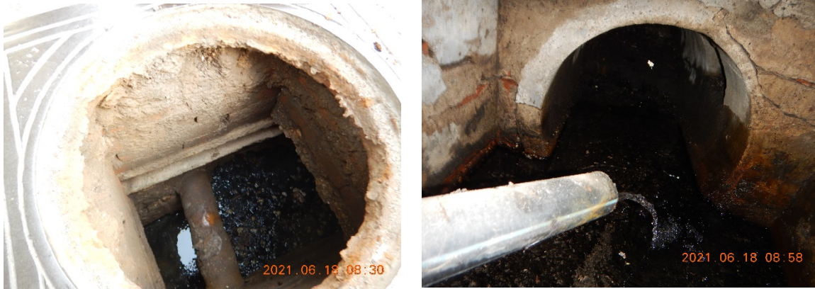
Figura 4 Esempi di pozzetti fognari nella piazza Manno
