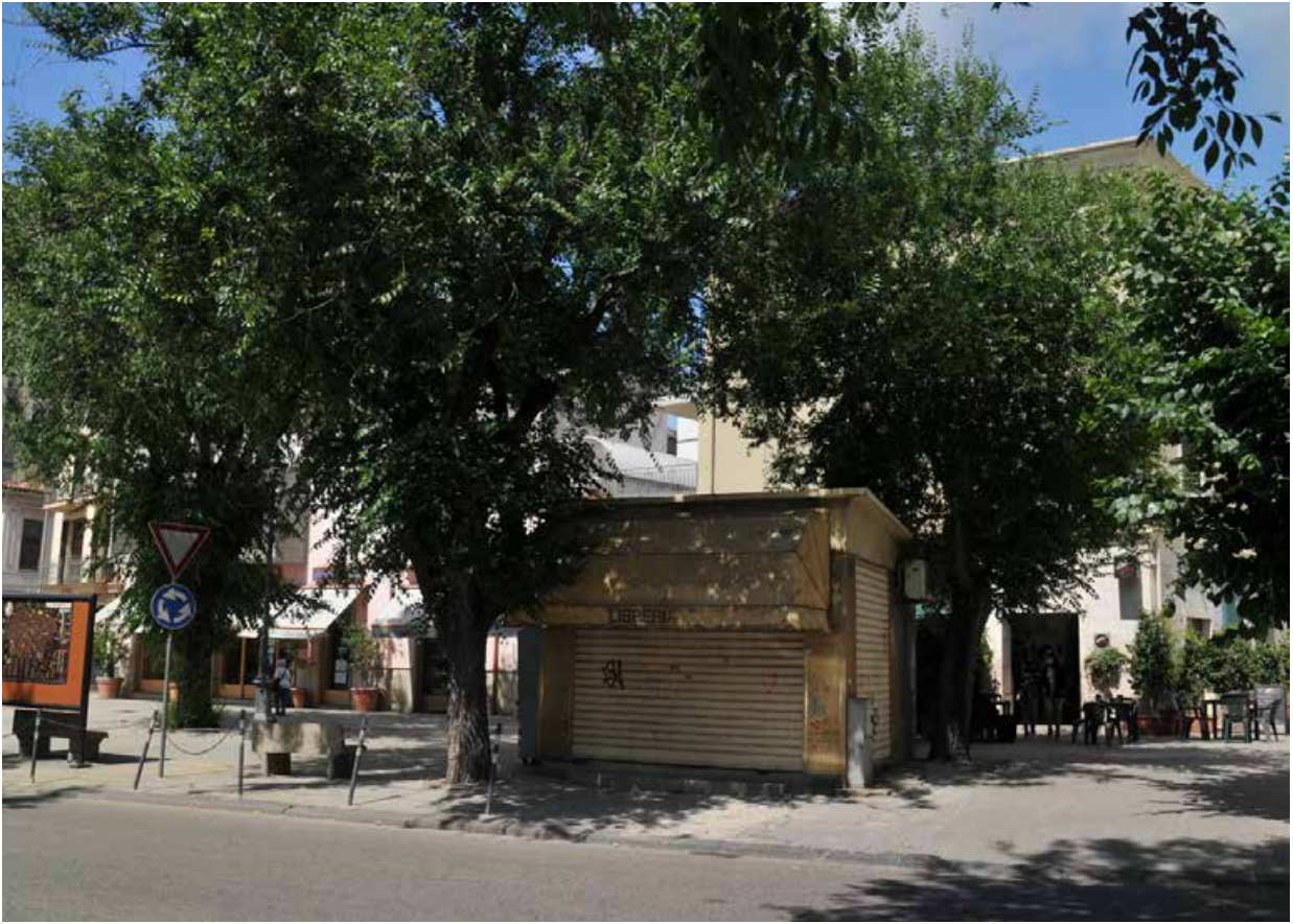
Foto n. 29 - Chiosco/libreria da demolire
