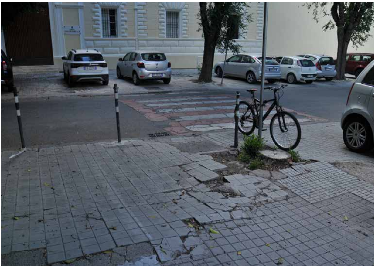
Foto n. 32 - Degrado pavimentazione
