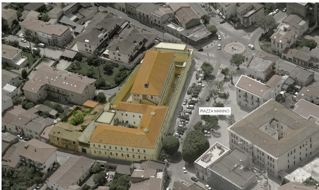
Il complesso architettonico delle Ex Carceri di Piazza Manno
