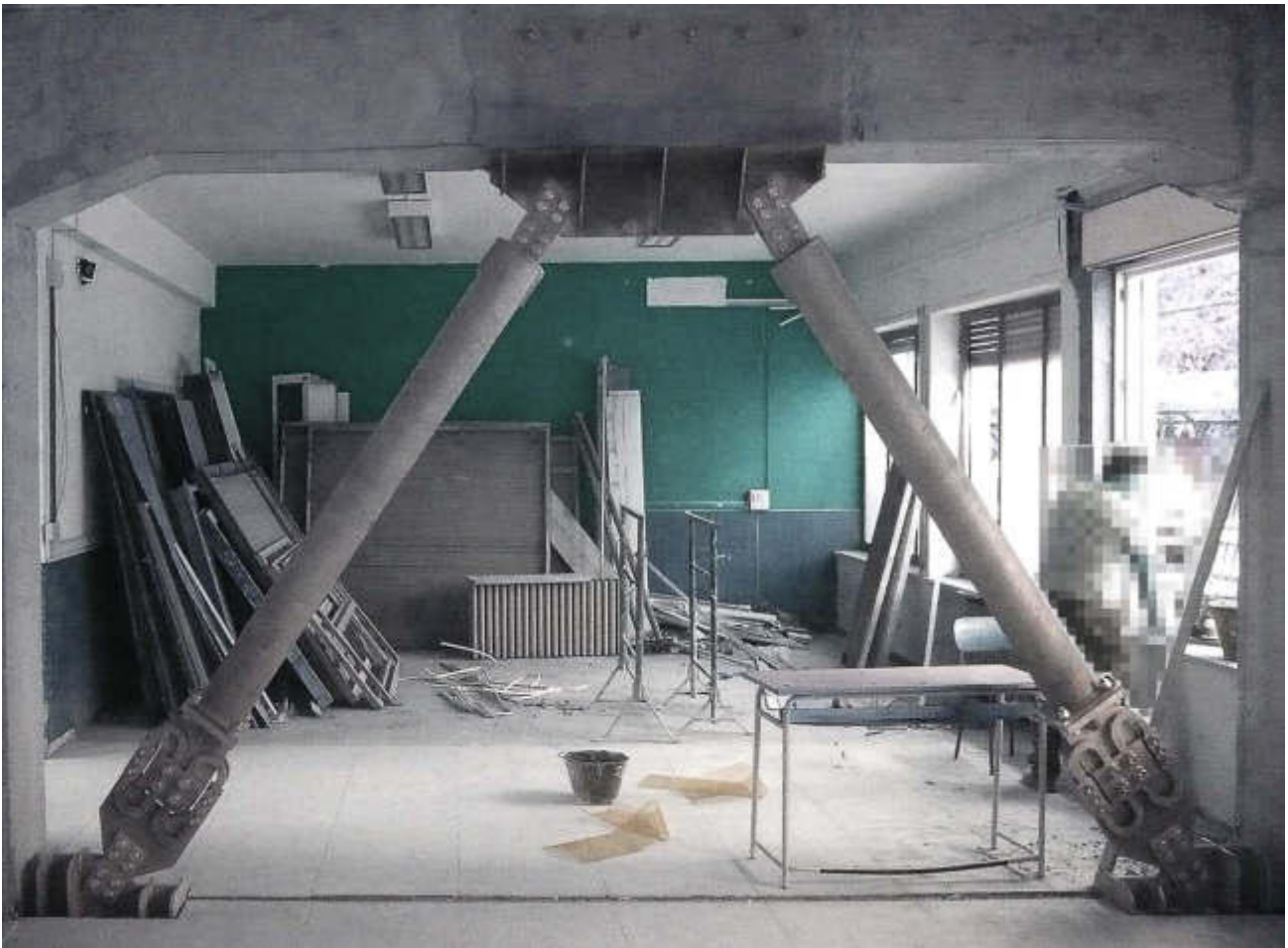
Installazione di controventi dissipativi
