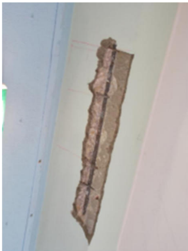
Prelievo barra armatura piano copertura
