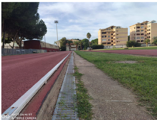
Cordolo esistente da rimuovere e sostituire
