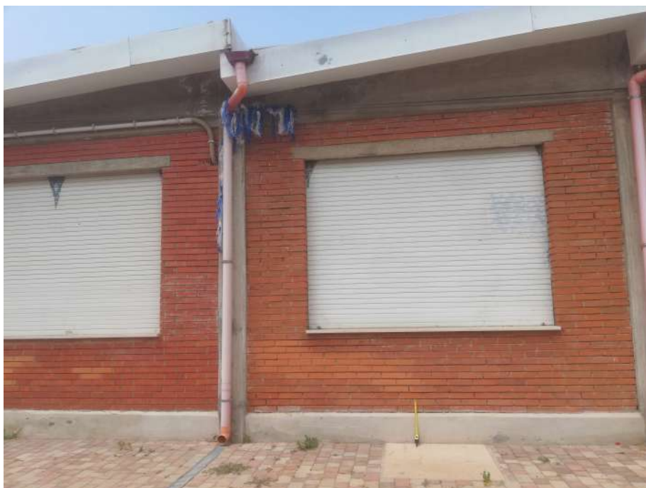
Figura 6 Apertura da trasformare in uscita d'emergenza
