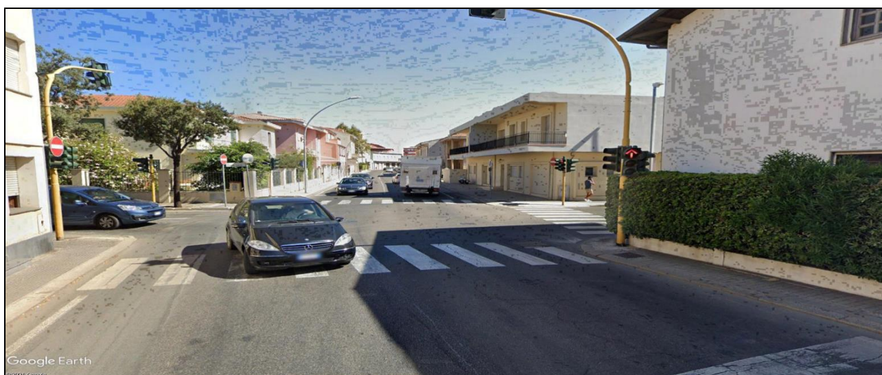
Figura 30 – Impianto semaforico Via Cairoli e Viale Diaz
