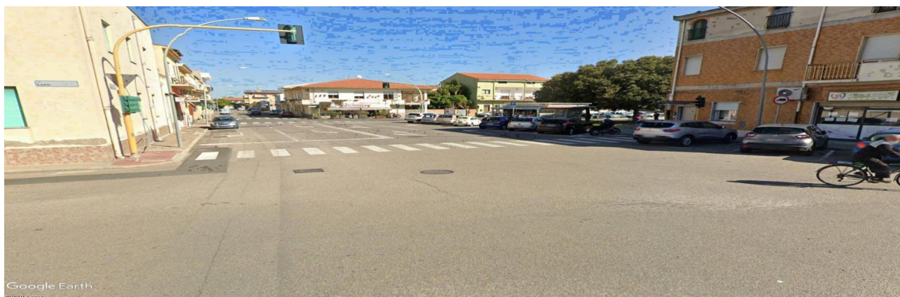
Figura 15 - Impianto semaforico in Via Carnia
