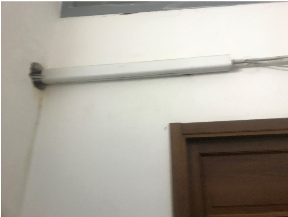
Particolare impianti esterni
