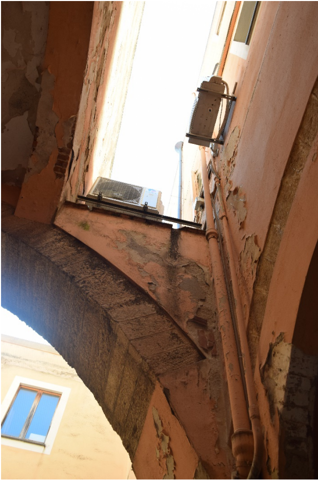
Particolare impianti a vista e intonaci degradati
