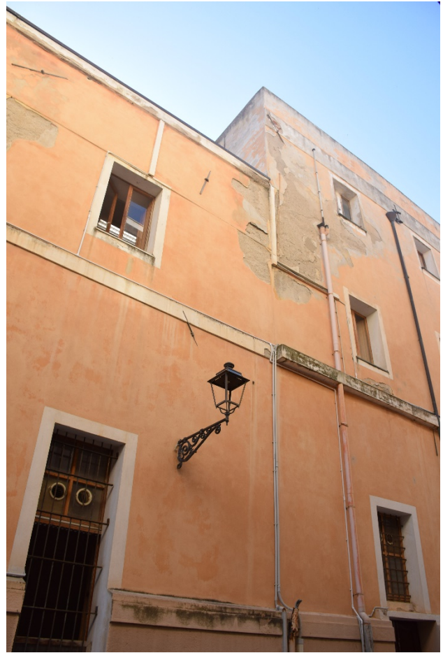
Parte centrale prospetto
