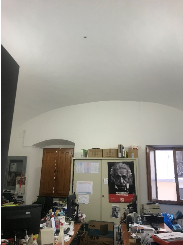
Uffici adiacenti aula consiliare
