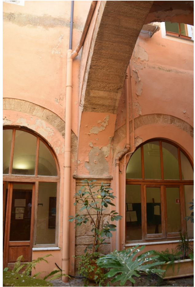
Particolare impianti a vista e intonaci degradati
