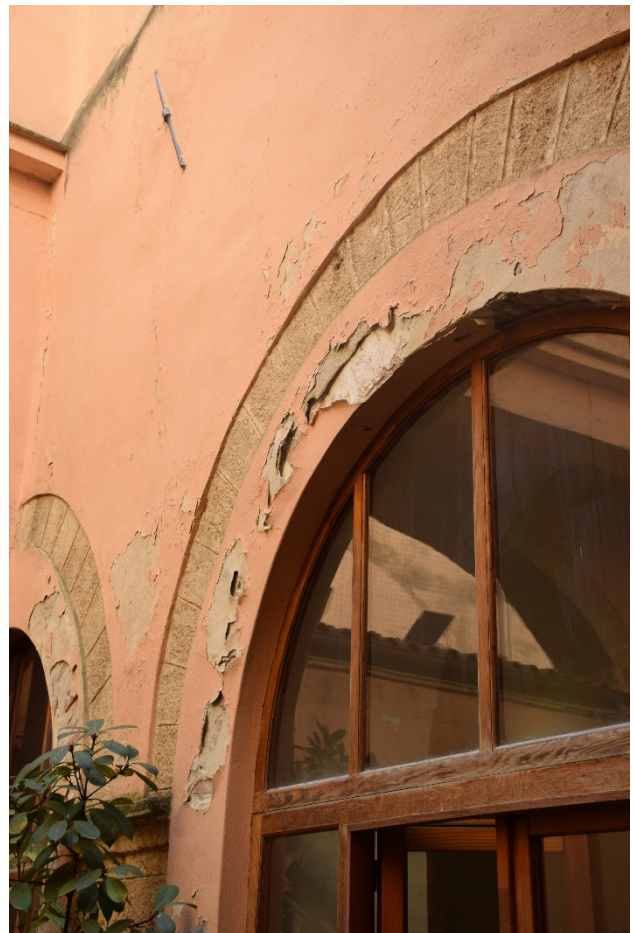
Particolare intonaci degradati
