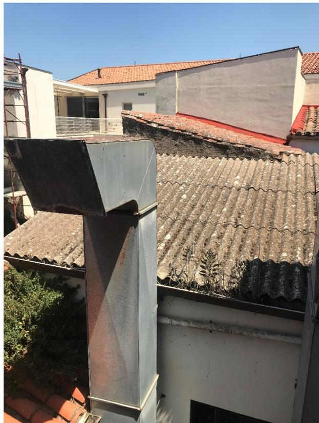
*Copertura in lastre di cemento amianto*
