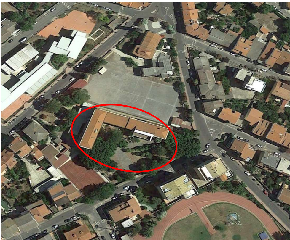
Figura 1 – Vista aerea del fabbricato
