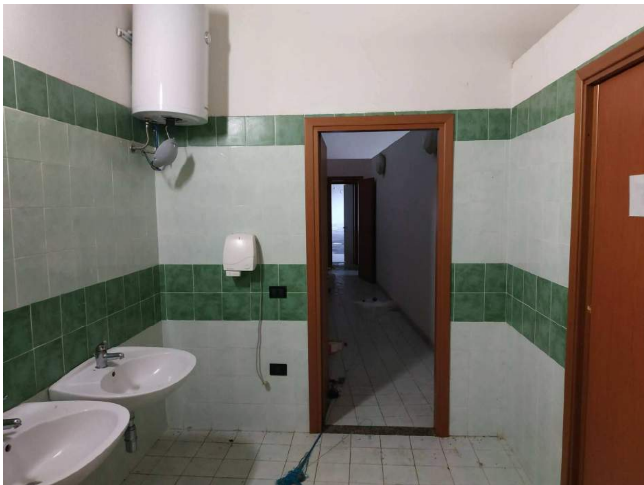
FOTO 11 - PIANO TERRA – SERVIZI IGIENICI
