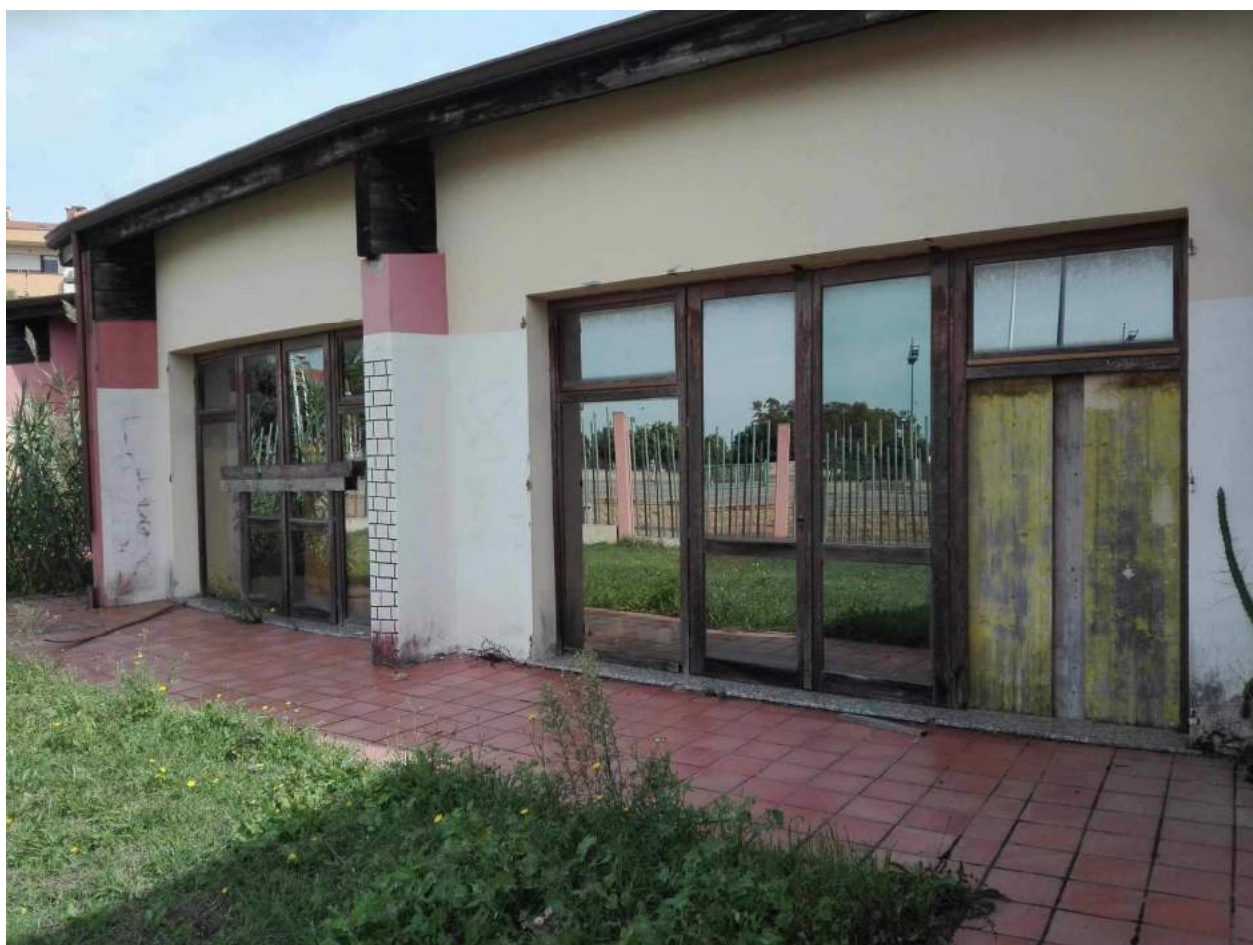
FOTO 5 - VISTA ESTERNA DELLA SALA DELLE ATTIVITÀ PER RAGAZZI
