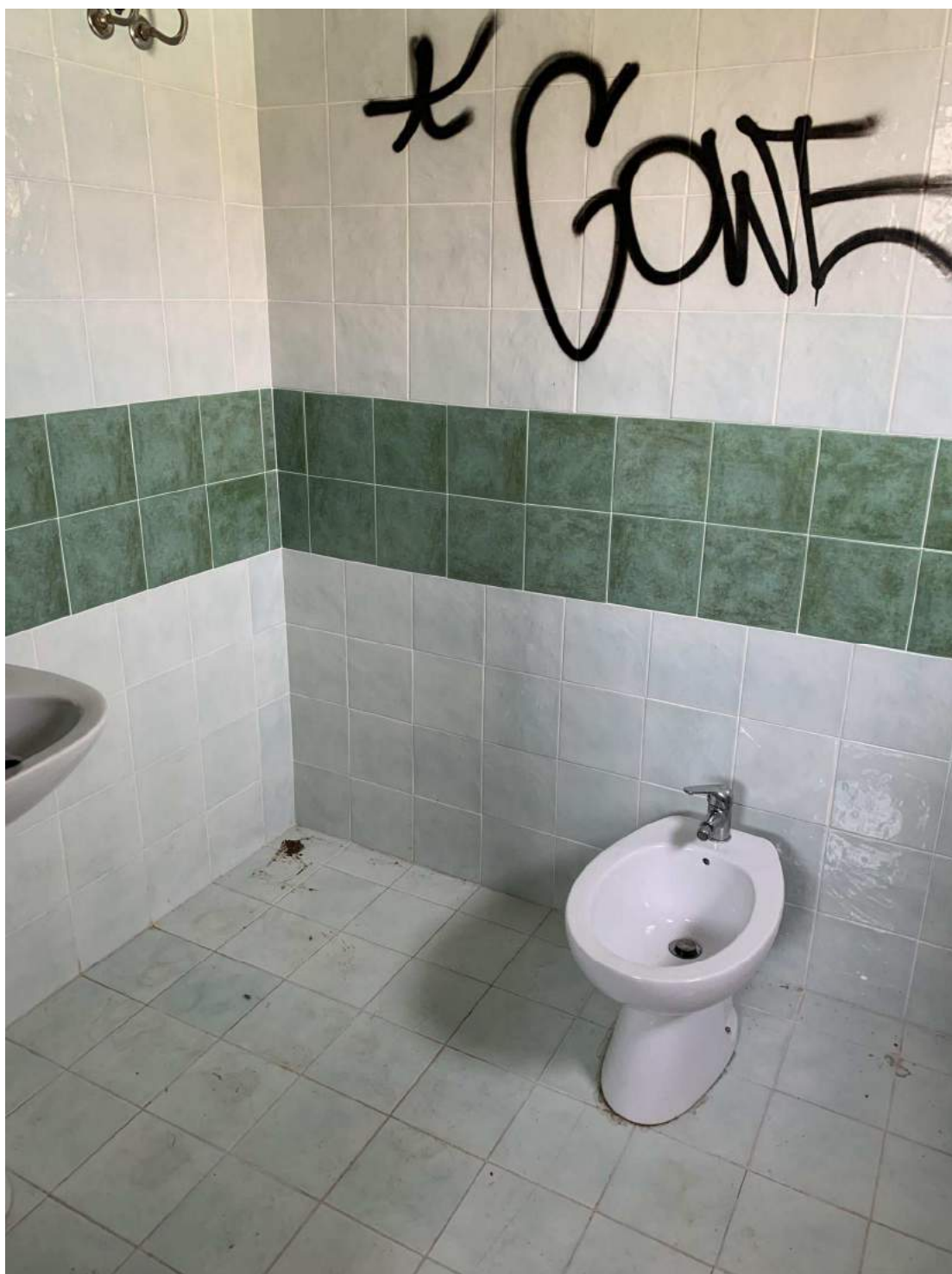
FOTO 18 - PIANO PRIMO – SERVIZI IGIENICI
