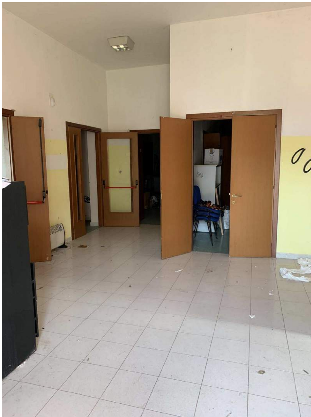
FOTO 7 - PIANO TERRA - INGRESSO
