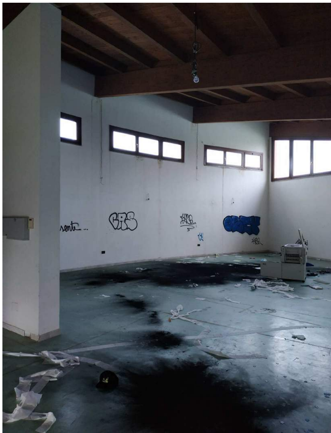
FOTO 17 - PIANO PRIMO – SALA ATTIVITÀ
