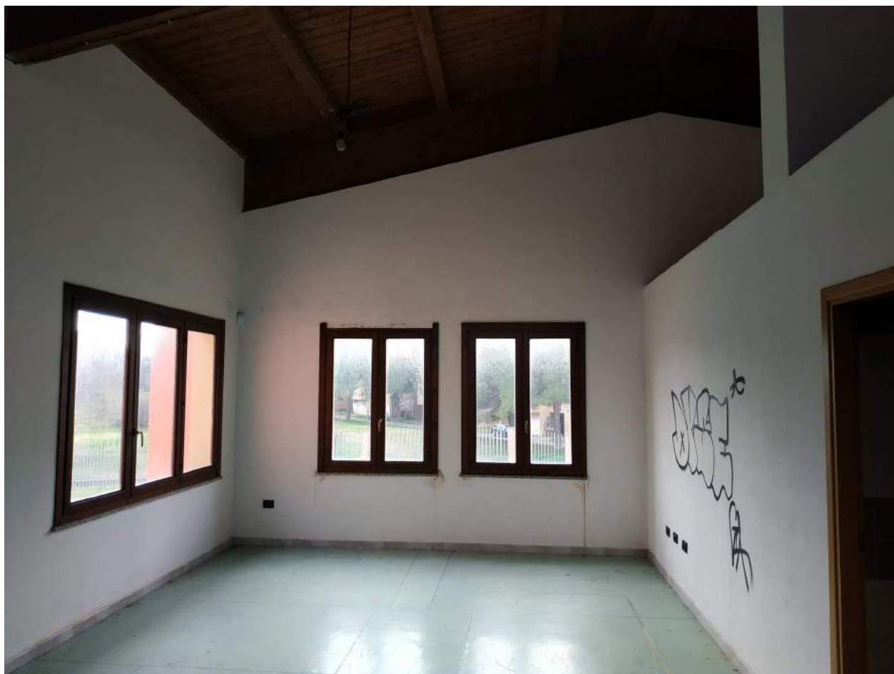
FOTO 16 - PIANO PRIMO – SALA ATTIVITÀ
