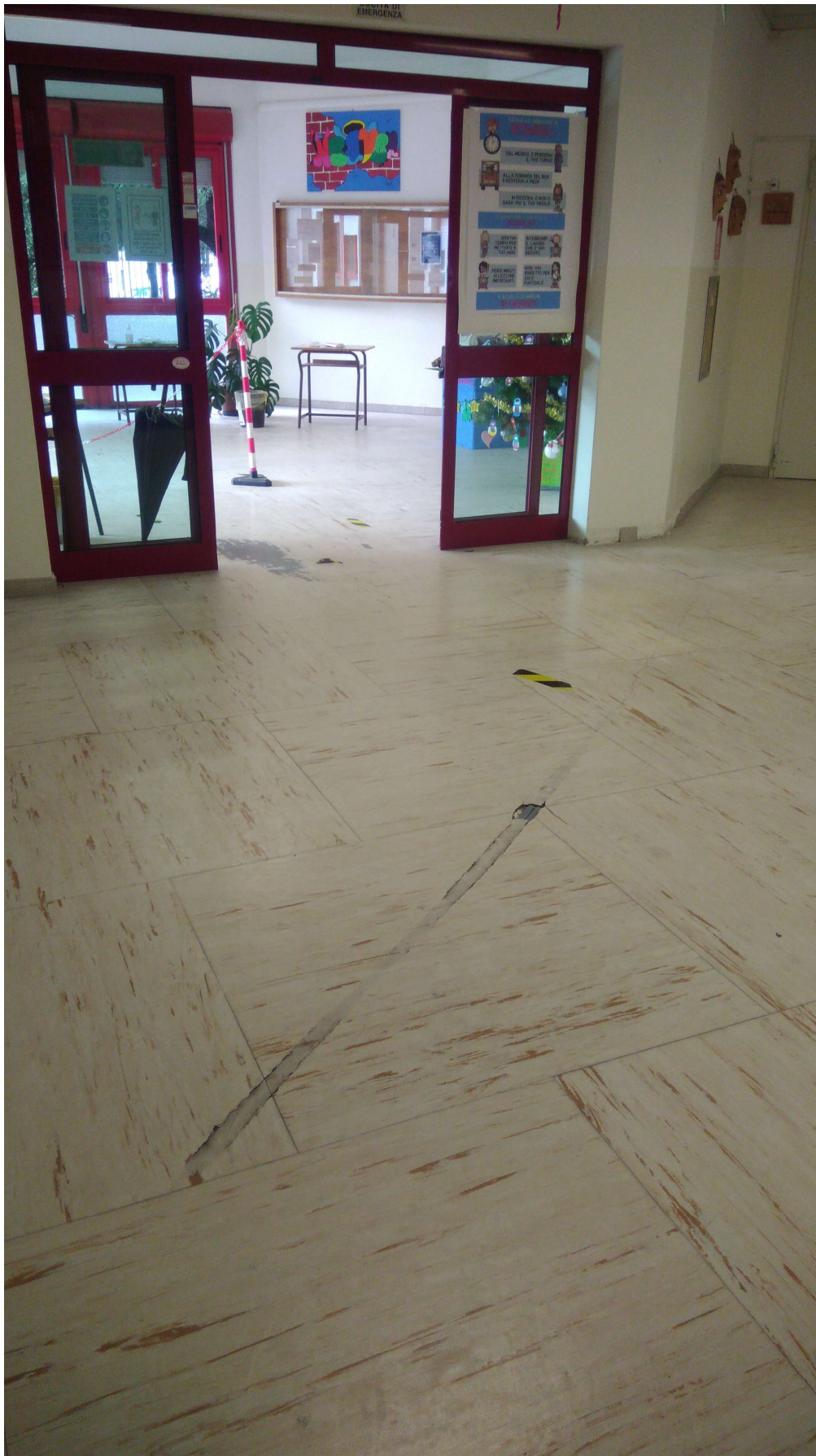
Pavimentazione da rimuovere
