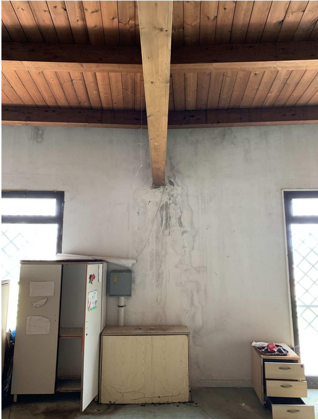
**FOTO 20 - PIANO TERRA – UMIDITÀ DI RISALITA VISIBILE NELLE PARETI DELLA SALA POLIFUNZIONALE**
