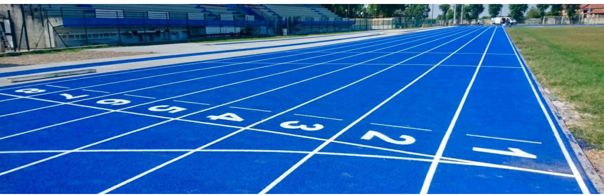
IMMAGINI A SINISTRA Esempio manto pista a lavori ultimati A DESTRA Dettaglio finitura manto
