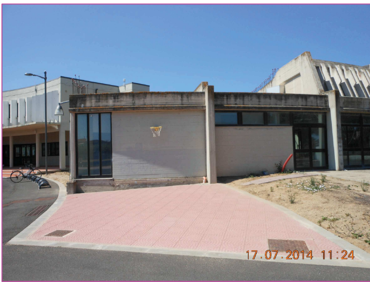
Veduta esterna dei locali da sistemare a servizio del Centro Giovani
