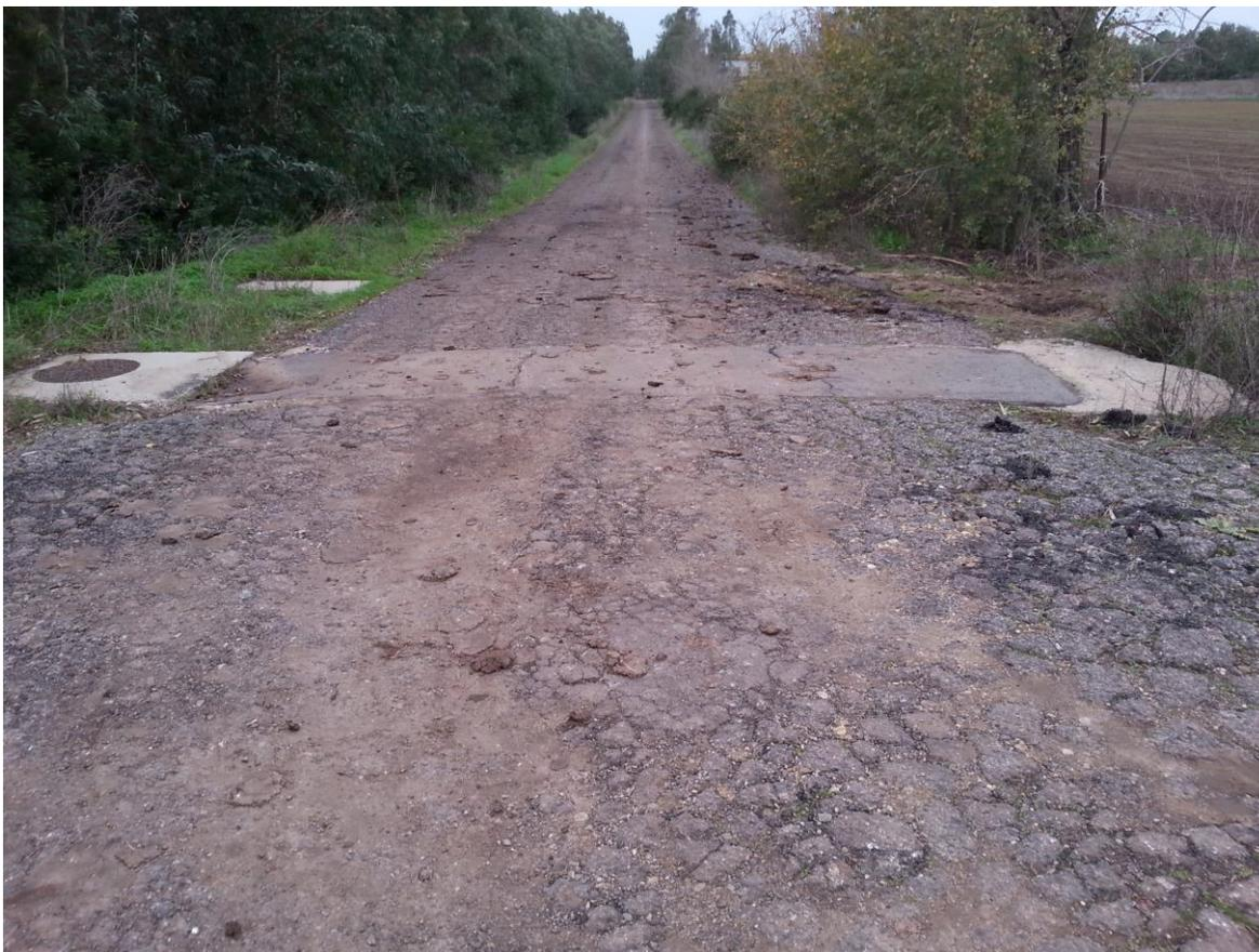
Così come rilevato dai sopralluoghi in situ, la strada si presenta generalmente costeggiata dai frangiventi di eucalipti che delimitano i poderi agricoli, si rileva una carreggiata avente una larghezza pari a m. 5.20, e un rivestimento stradale costituito da conglomerato bituminoso avente spessore di cm. 6, banchine in terra e fossi di guardia laterali aventi larghezza media di circa 1.50 m..
