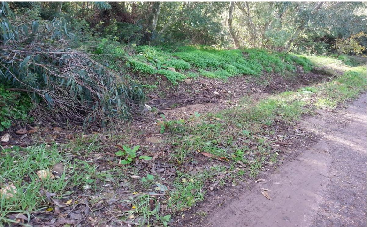
A causa della situazione sopra esposta, che determina anche fenomeni di erosione delle banchine laterali, si rende imprescindibile un deciso intervento di manutenzione straordinaria che ripristini le normali condizioni di sicurezza e transitabilità.
