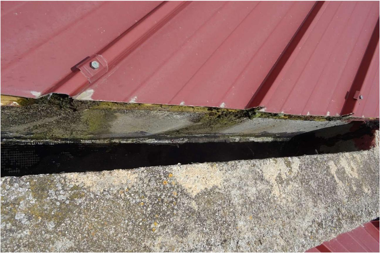
Particolare della testa del pannello di copertura
