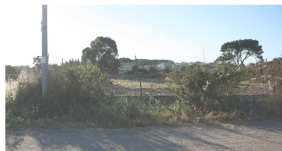
Traffo iniziale lato nord-est
