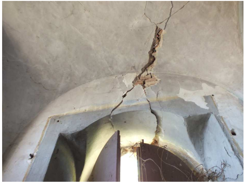
Prospetto principale - piano terra ingresso sala lato ovest, lesione passante.
