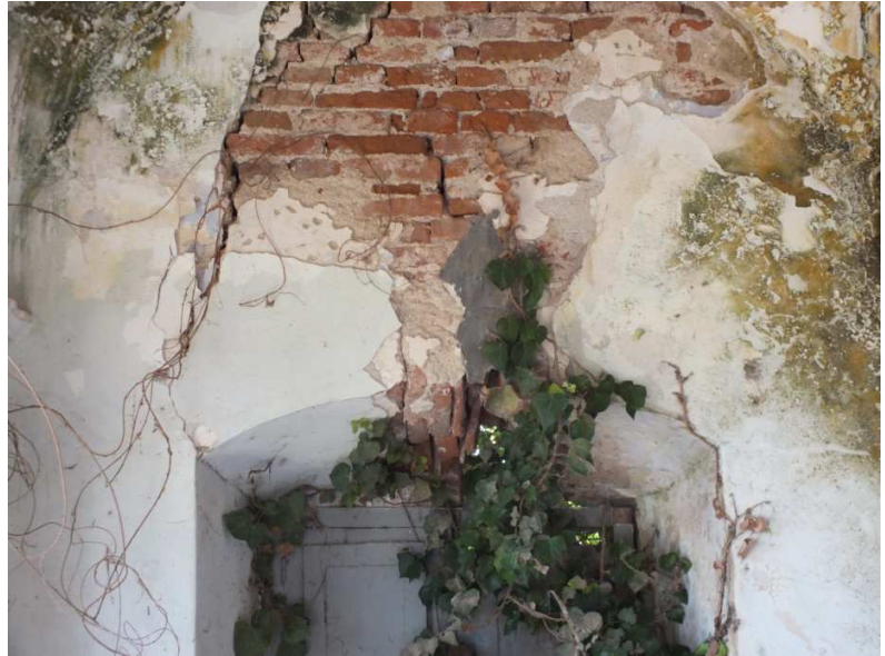
Prospetto principale - piano terra ingresso sala lato ovest, lesione passante.
