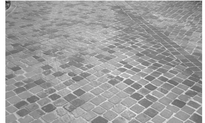
Pavimentazione in cubetti di basalto disposti in diagonale con posa regolare
