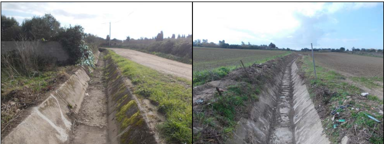
Figura 6: Canalette di dreno in cls immediatamente a monte dell'area oggetto degli interventi in progetto
