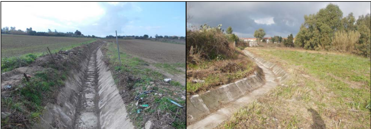
Figura 10: Canaletta ovest rispettivamente a monte e in corrispondenza dell’area in cui si prevede di realizzare la vasca di laminazione di monte, come si può vedere in questo tratto le canalette si sono rivelate in buono stato di manutenzione.
