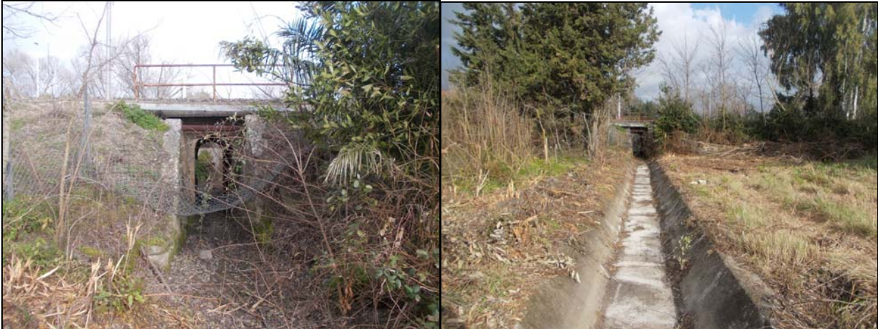
Figura 5: Rilevato e attraversamento ferroviario a monte dell'abitato di Sili in corrispondenza del canale di dreno est
