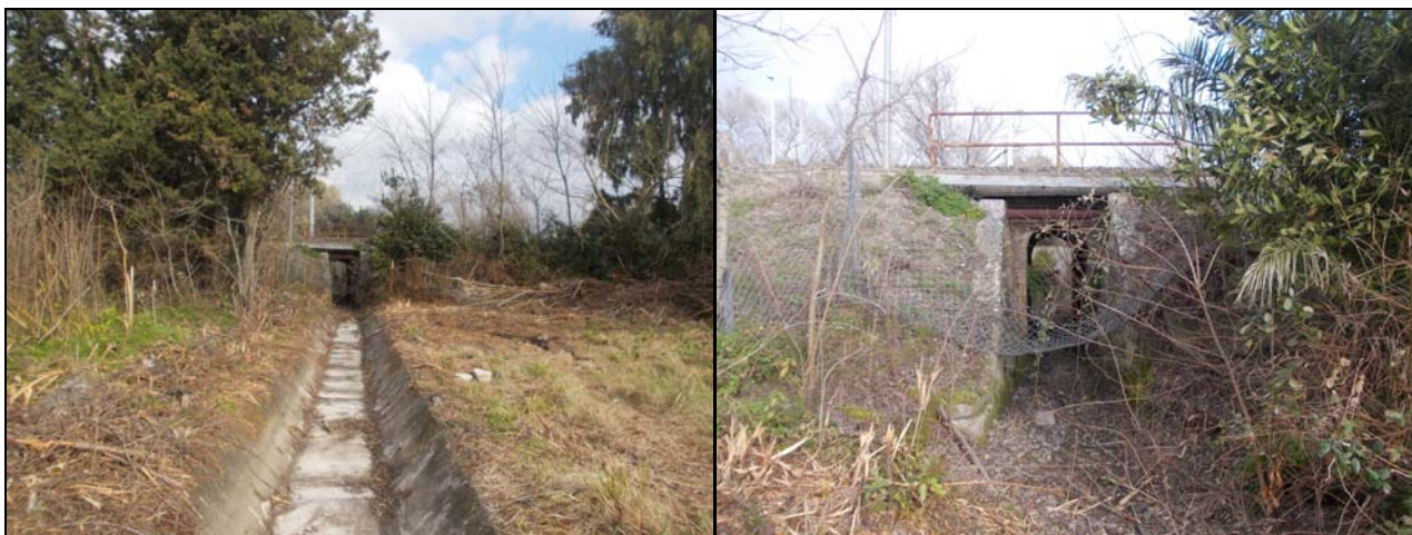
Figura 7: Attraversamento del rilevato ferroviario in corrispondenza del “canale Est”
