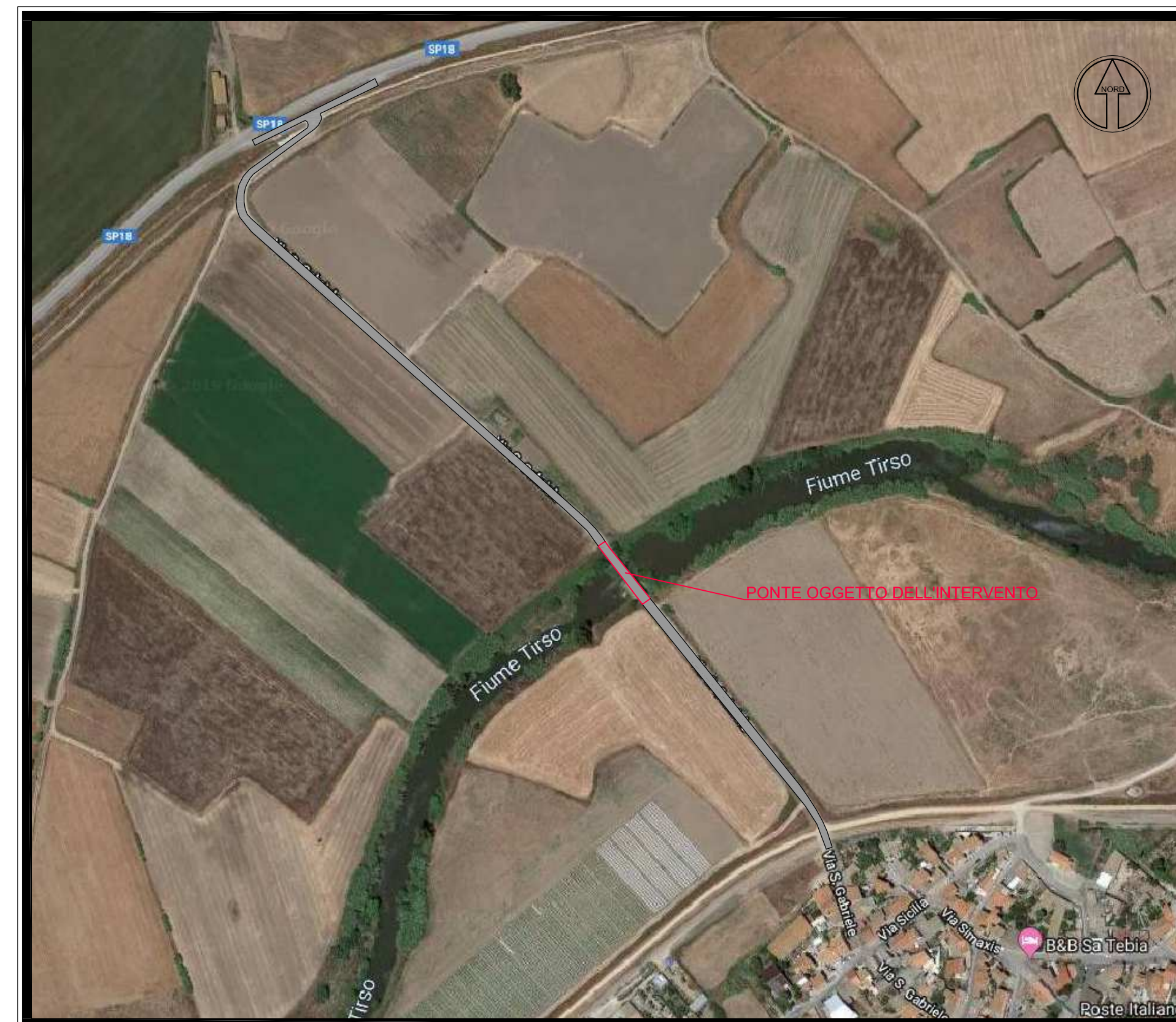
VISTA AEREA fuori scala
