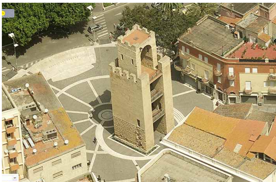
Torre di Mariano II – vista sud-est
