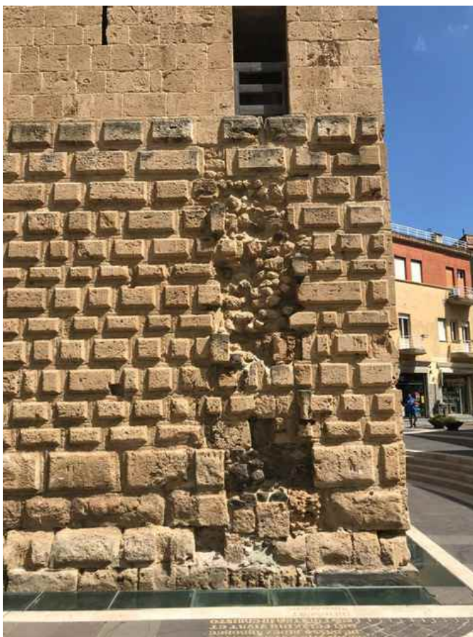
Muratura a sacco a vista sul paramento murario
