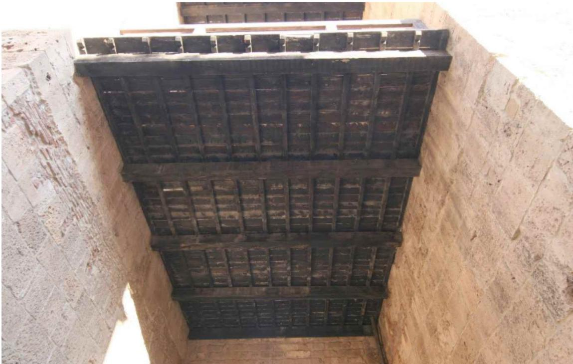
FOTO n° 8: l'impalcato del primo livello, si notano le colature di guano dei piccioni
