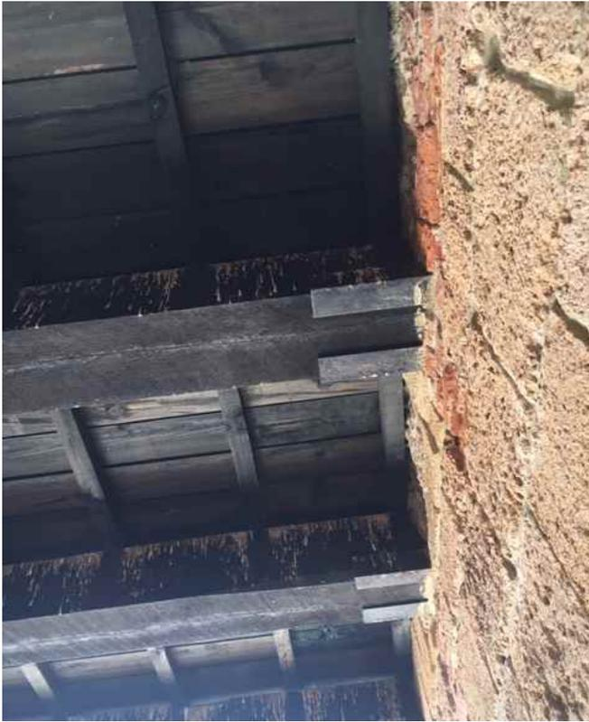
FOTO n° 20: Solaio del 3° livello visto da 2° (*Dett. Incastro trave con rinforzo in ferro*)
