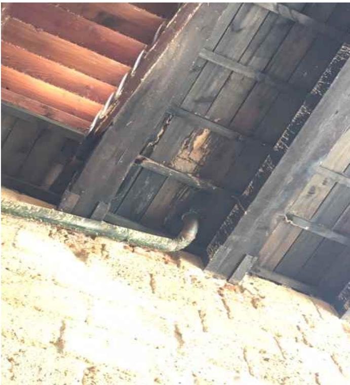
[ FOTO n° 19: Solaio del 3° livello visto da 2° (*Dett. Scarico pluviale in rame*)
