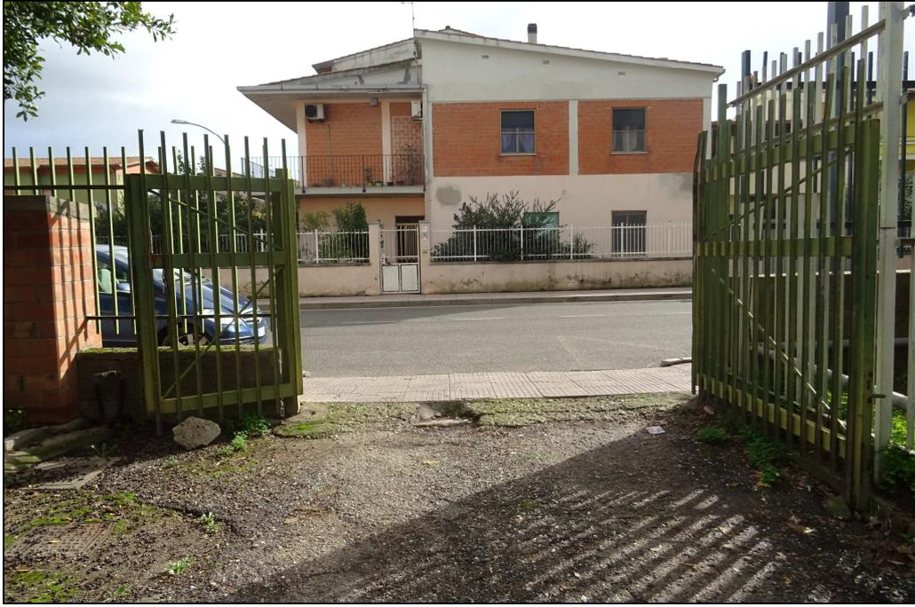
FOTO **5**, CANCELLO DA SOSTITUIRE ED AMPLIARE A **METRI 4 DI LUCE NETTA** (DIMENSIONE COMPLESSIVA METRI 4,50) PER CONSENTIRE L'INGRESSO DEI MEZZI DEI VIGILI DEL FUOCO
