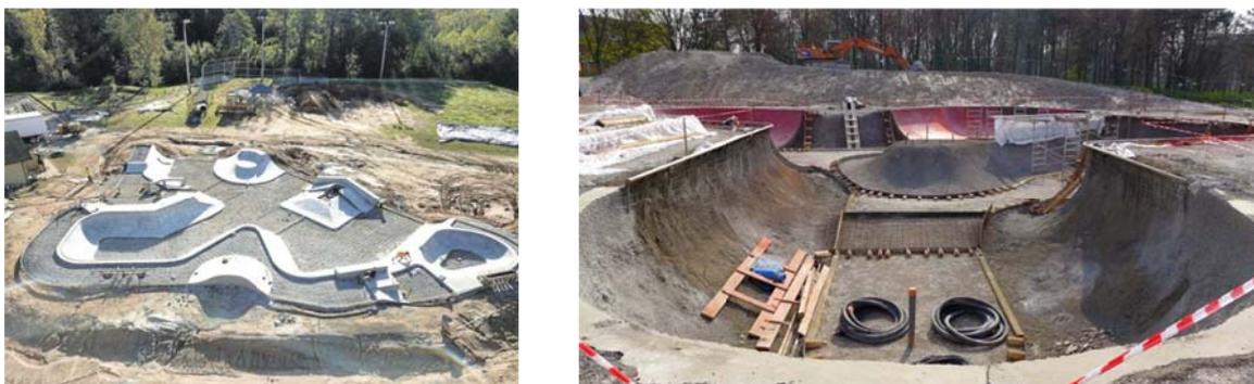
Fig.6 – Esempi di park in cemento armato in fase di realizzazione [Fonte: WEB]
