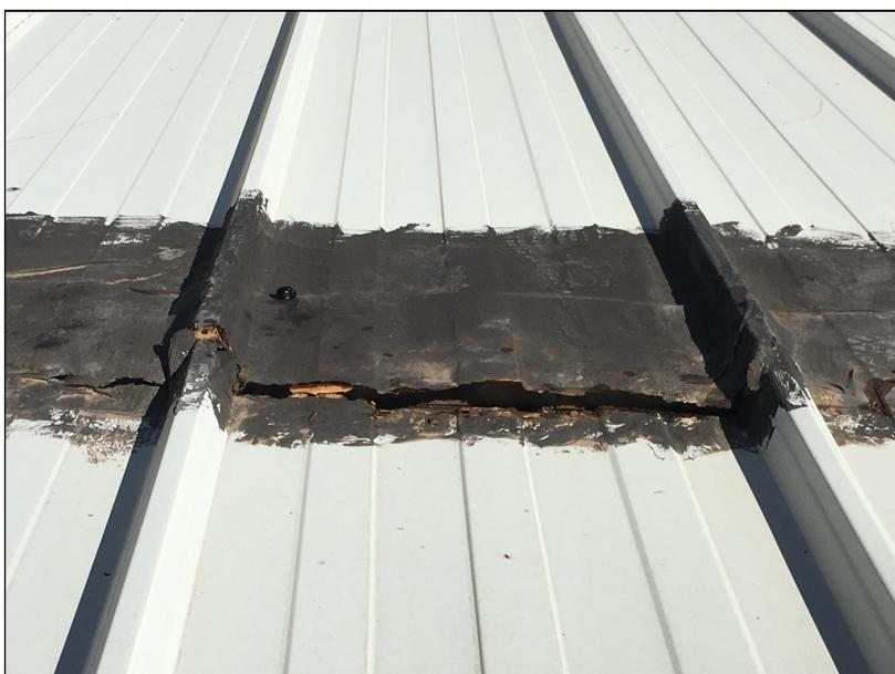
FOTO **2**, INFILTRAZIONI CAUSATE ALLA INADEGUATA SOVRAPPOSIZIONE DELLE LASTRE
