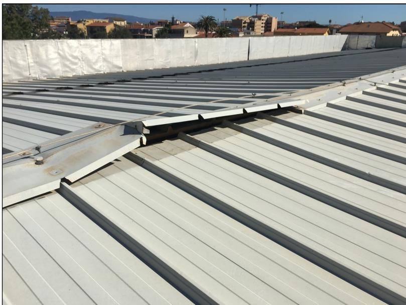
FOTO **1**, MANTO DI COPERTURA – LAMIERA DI COLMO DA SOSTITUIRE
