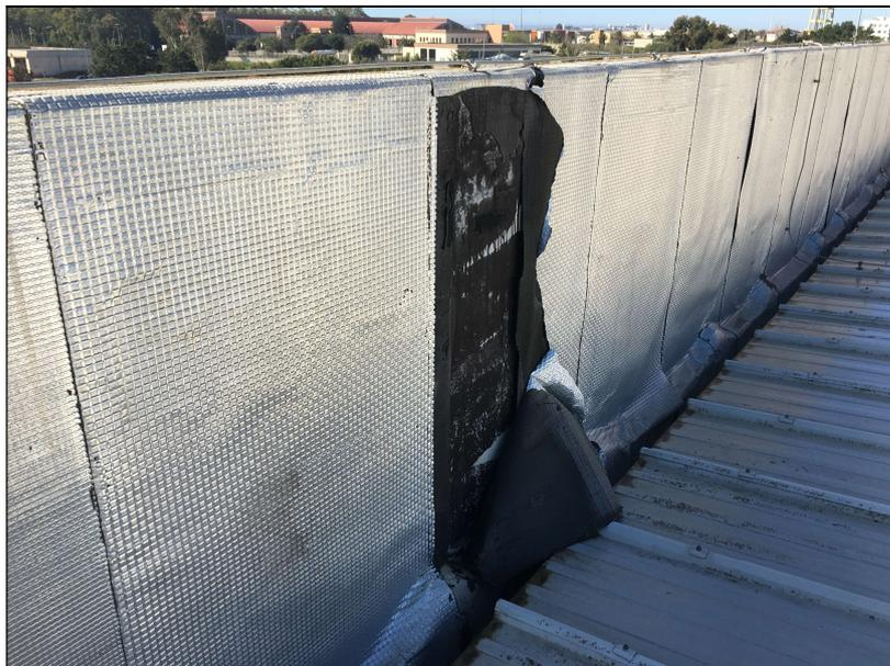
**FOTO 3, DISTACCO DELLA GUAINA DI IMPERMEABILIZZAZIONE – VISTA 1**
