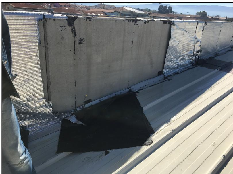
**FOTO 4, DISTACCO DELLA GUAINA DI IMPERMEABILIZZAZIONE – VISTA 2**
