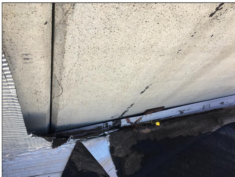
**FOTO 4, DISTACCO DELLA GUAINA DI IMPERMEABILIZZAZIONE – PARTICOLARE**
