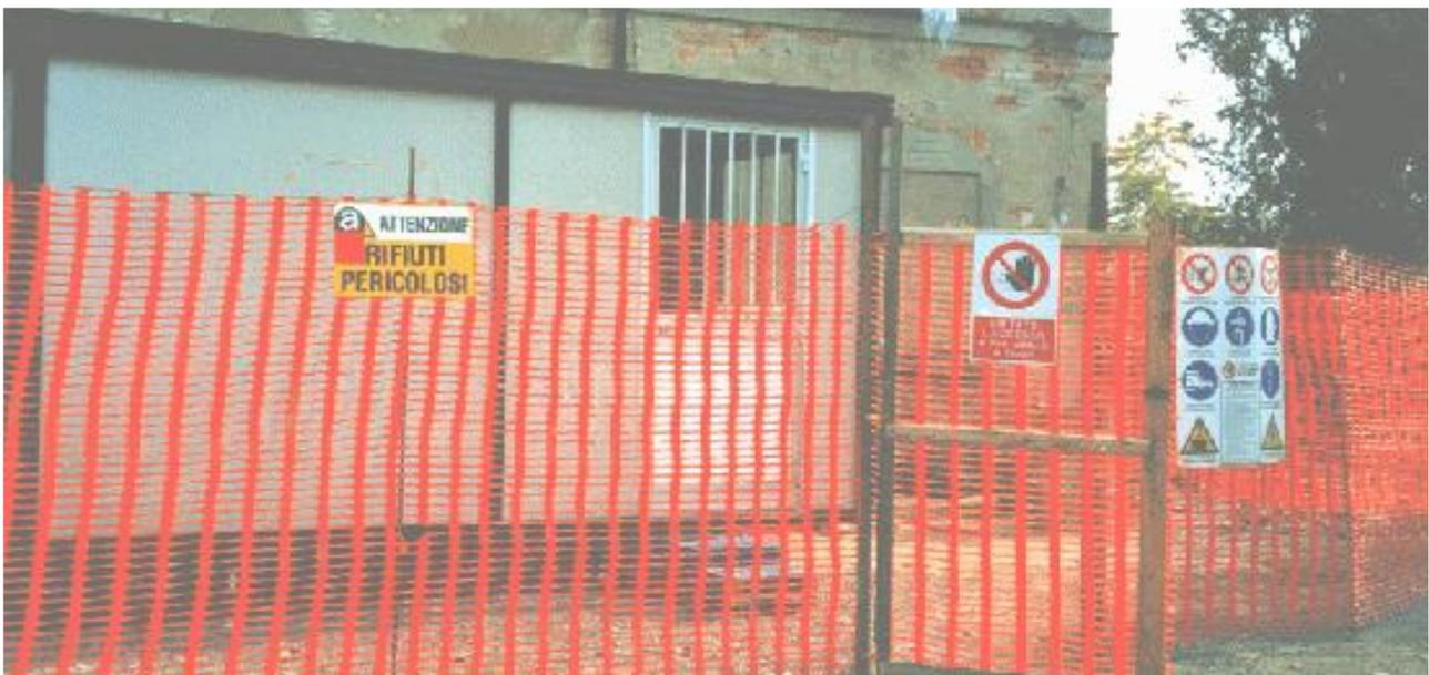
Le operazioni di rimozione delle lastre di cemento amianto possono comportare la liberazione di fibre di amianto e pertanto le aree di cantiere devono essere interdette al personale non autorizzato, delimitandole, e il pericolo va segnalato con una apposita cartellonistica, evitando peraltro frasi
