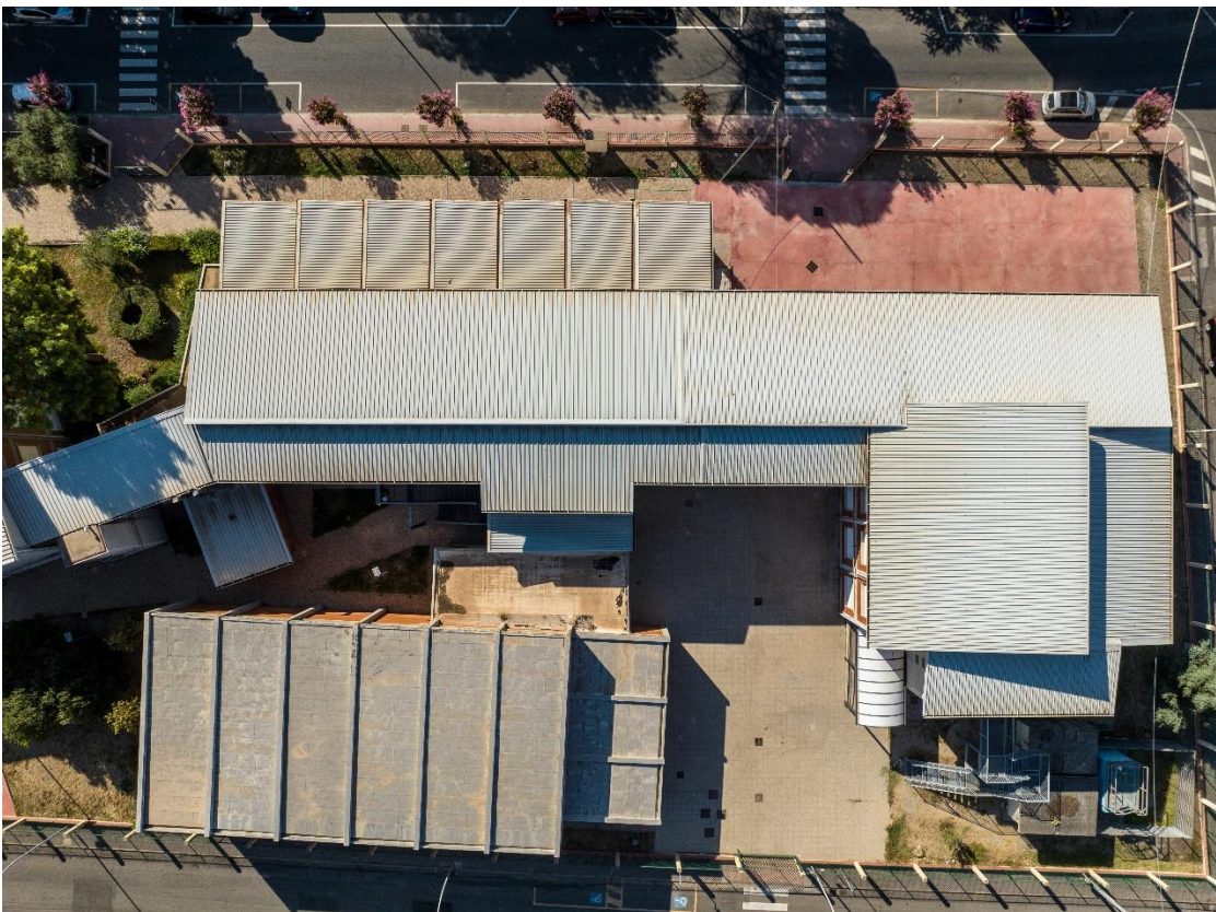
Figura 3: Vista della copertura con due tipologie, quella a destra e sopra in lamiera grecata, e quella a sinistra con pannello coibentato grecato sopra la copertura in cemento-amianto
