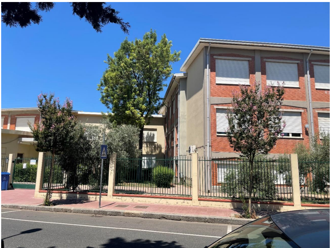
Figura 7: Prospetto anteriore della zona di intervento
