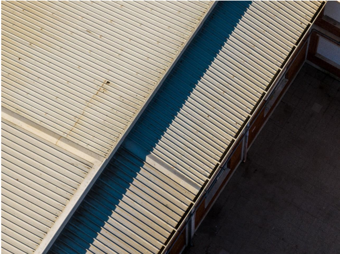
Figura 4: Vista della copertura con due tipologie, quella in alto (lamiera grecata), e quella in basso (pannello coibentato grecato sopra la copertura in cemento-amianto)
