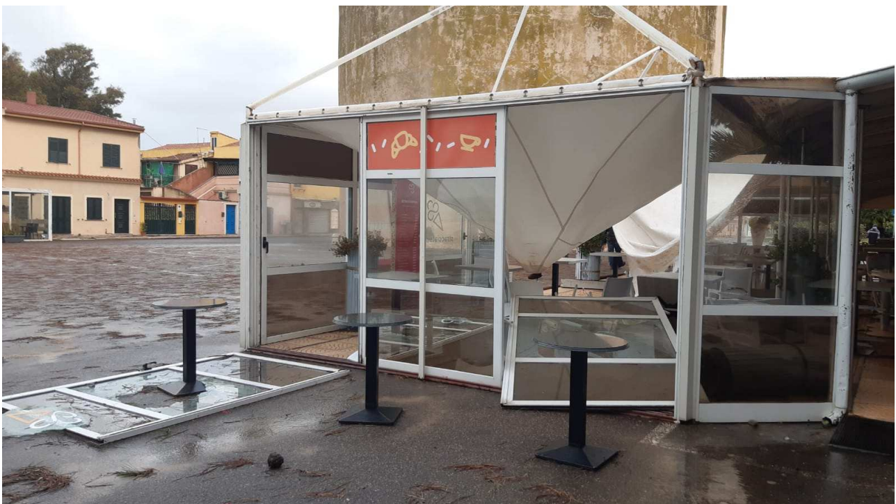
Foto 14 - Torregrande - Lungomare, Chiosco danneggiato dal vento
