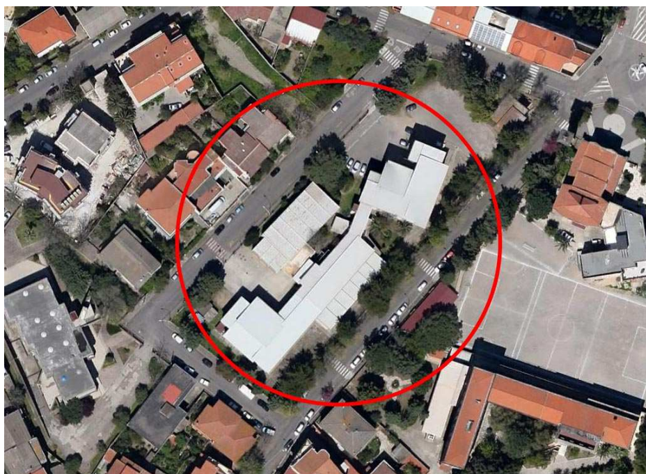
Figura 1: Ubicazione Scuola Primaria di via Amsicora
