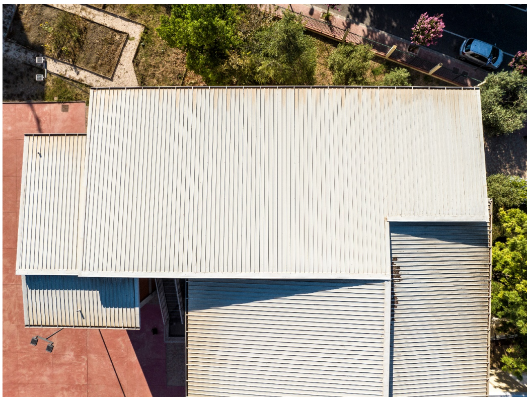
Figura 5: Vista della copertura nella zona di intervento (pannello coibentato grecato sopra la copertura in cemento-amianto)
