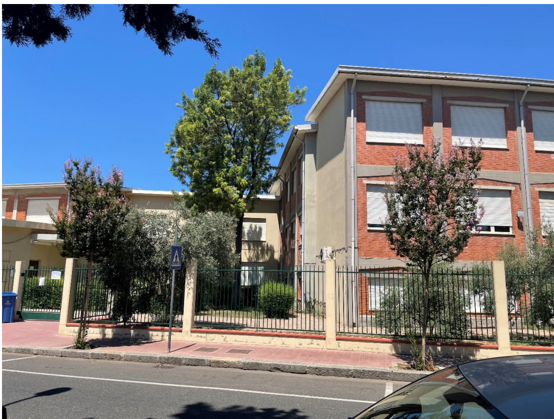
Figura 7: Prospetto anteriore della zona di intervento
