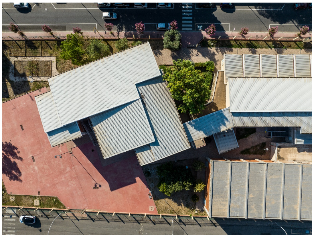
Figura 6: Vista della copertura nella zona di intervento (pannello coibentato grecato sopra la copertura in cemento-amianto)
