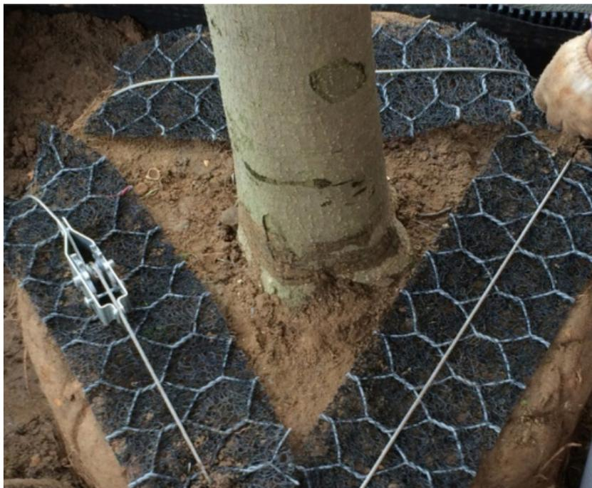
Figura 19: protezione e stabilizzazione della zolla tramite ancore sotterranee
