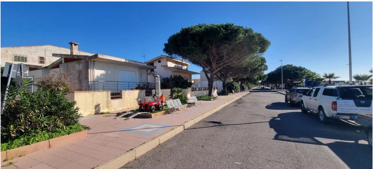
Foto 2: realizzazione prova penetrometrica Dpsh2.
