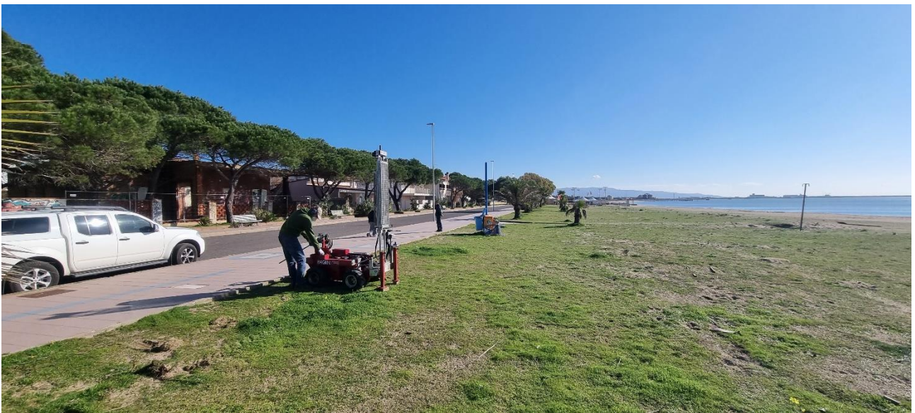
Foto 3: realizzazione prova penetrometrica Dpsh3.
