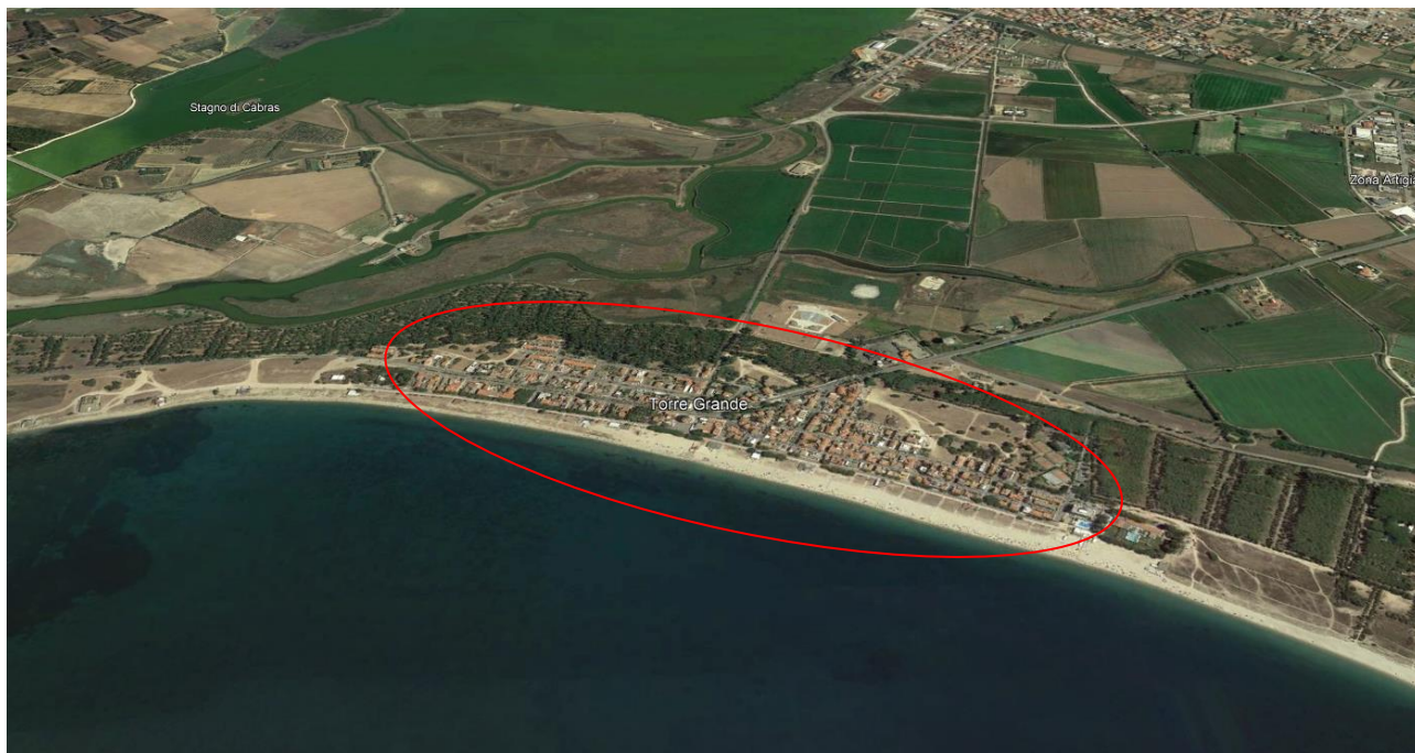
Figura 6. Panoramica area d'intervento.
