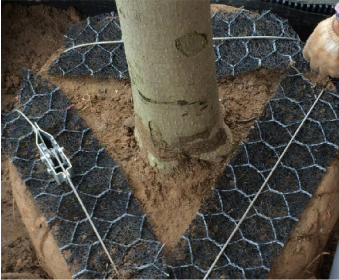
Figura 8: protezione e stabilizzazione della zolla tramite ancore sotterranee
