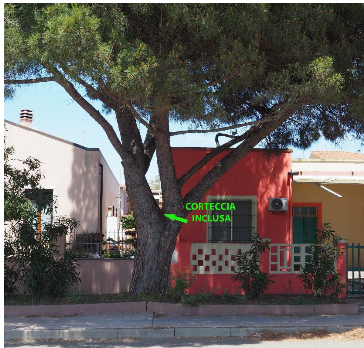
Figura 5: la presenza di corteccia inclusa all'inserzione rappresenta una situazione di potenziale rischio
