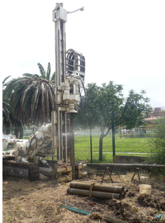
Foto 4: Esecuzione sondaggi (S7)
