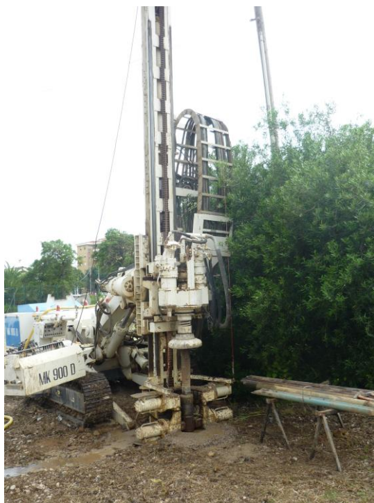
Foto 3: Esecuzione sondaggi (S6)
