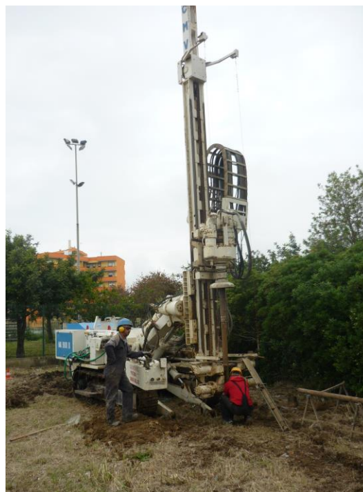
Foto 2: Esecuzione sondaggi (S4)
