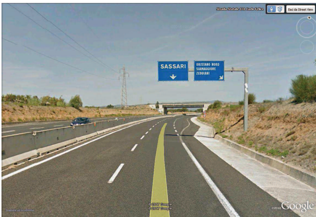
Foto n° 1 - ritto portale a bandiera S.S. 131 in di rezione Cagliari- Sassari al km 98+486
