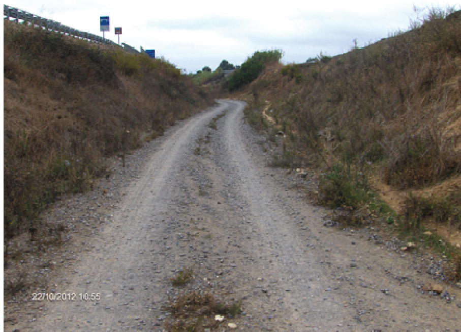
Foto n° 27.1 –Strada C, reliquato ex SS 131 (a dx) e rilevato SS 131 (a sx) (bonifica, fondazione misto stabilizzato, cunette, scavo reliquato zona 2 )
