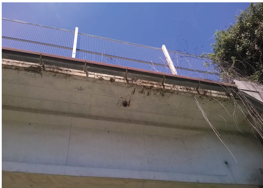
Foto n° 15.2 – Cavalcavia/ Cavalcaferrovia esistente (lato Simaxis). Smontaggio canaletta metallica, rete parasassi, paletti e barriera bordo ponte (Int.1). Risanamento intradosso impalcato previa asportazione corticale e passivazione ferri.
