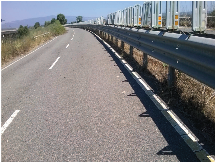
Foto n° 15.3 – Reliquato ex S.S. 131 (Zona 3) ( fresatura pavimentazione stradale, posa di terra vegetale e piantumazione, profilatura scarpata, smontaggio/rimontaggio barriera centrale e smontaggio frangiluce (Int.1))
