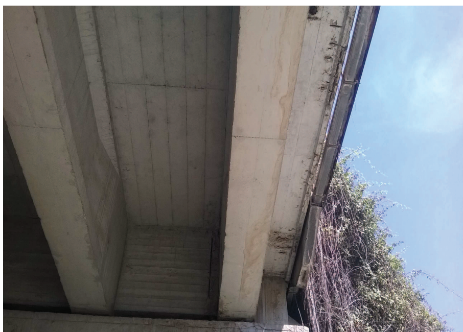
Foto n° 18.2 – Cavalcavia/ Cavalcaferrovia esistente (lato Simaxis). Smontaggio canaletta metallica, rete parasassi, paletti e barriera bordo ponte (Int.1).
