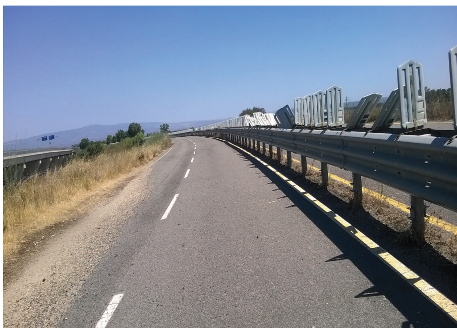
Foto n° 12.3 – Reliquato ex S.S. 131 (Zona 3) (rimozione barriere, fresatura pavimentazione stradale, posa di terra vegetale e piantumazione, profilatura scarpata, smontaggio rimontaggio barriera centrale e smontaggio frangiluce (Int.1) )
