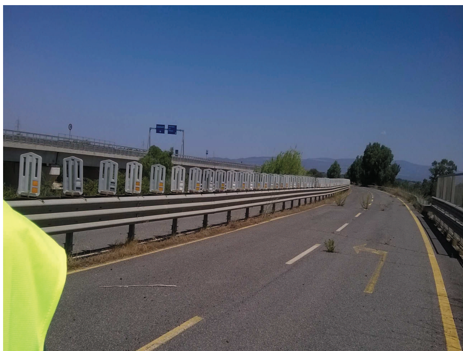
Foto n° 18.1 – Reliquato ex SS 131 pressi sottopasso (smontaggio barriera bordo laterale, smontaggio rete parasassi e paletti, cancellazione segnaletica, smontaggio/montaggio barriera centrale, sfalcio erba, smontaggio frangiluce, riparazione buche pavimentazione)
