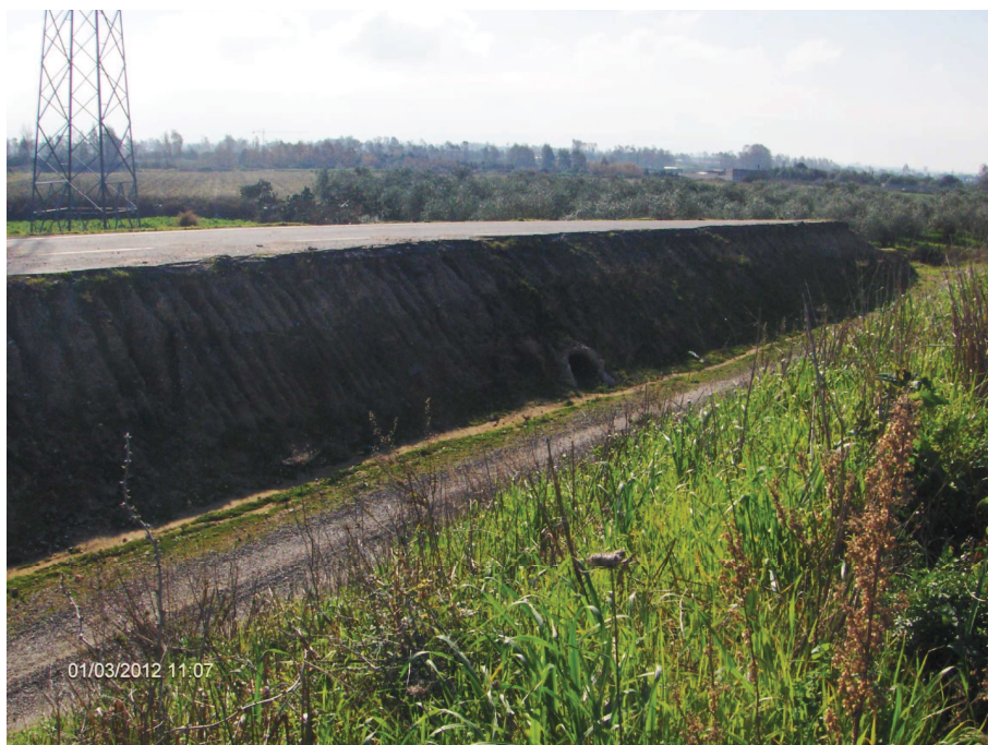
Foto n° 2.3 – Reliquato ex S.S. 131 (zona 2) (demolizione pavimentazione stradale e scavo sbancamento)
