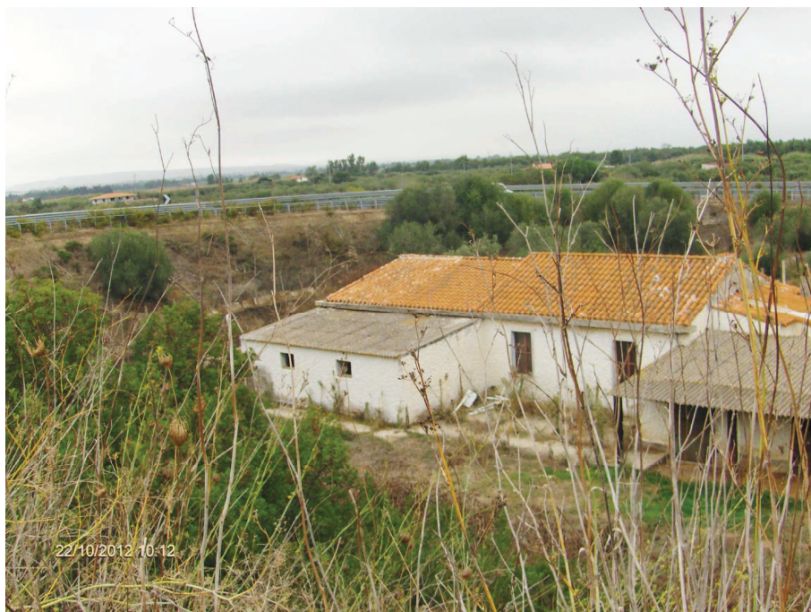
Foto n° 4.1 – Immobile acquisto da ANAS c/o area di svincolo Oristano-Silì fianco rampa / strada A (ammorsamento scarpata, realizzazione rilevato, allungamento tubolare \phi 1000 )
