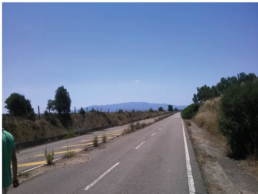
Foto n° 2.4 – Reliquato ex S.S. 131 "Oristano Nord" (fresatura pavimentazione stradale, cordona stradale, posa di terra vegetale e piantumazione)
