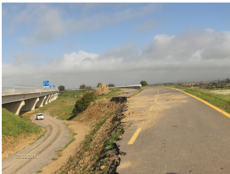
Foto n° 26.1 – Incrocio tra Strada B, ex reliquato SS 131 e Strada C (demolizione pavimentazione e scavo reliquato zona 2, bonifica, fondazione misto stabilizzato)
