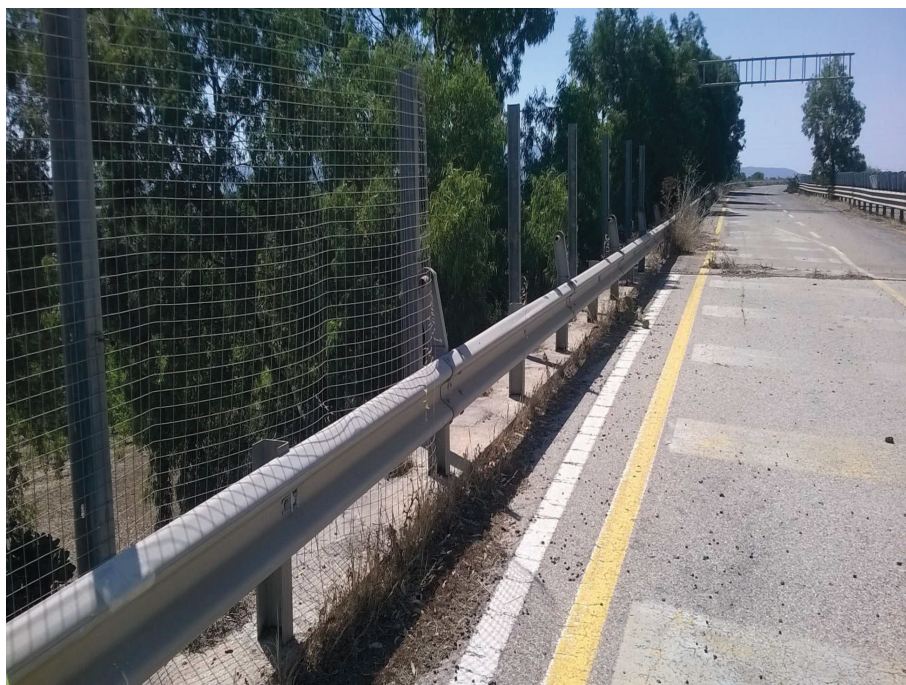
Foto n° 10.1 – Cavalcavia reliquato ex SS 131 (smontaggio barriera bordo ponte, taglio paletti non recuperabili, smontaggio rete parasassi e paletti, cancellazione segnaletica esistente e zebratura )
