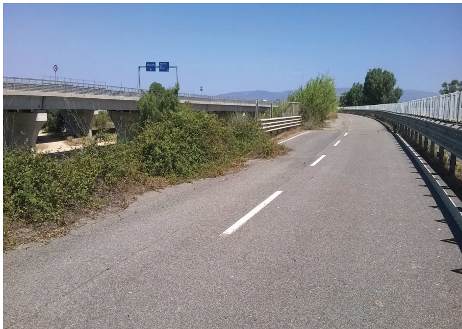
Foto n° 13.3 – Reliquato ex S.S. 131 (Zona 3) ( fresatura pavimentazione stradale, posa di terra vegetale e piantumazione, profilatura scarpata, rimozione barriere, paletti e rete antisasso (Int.1))
