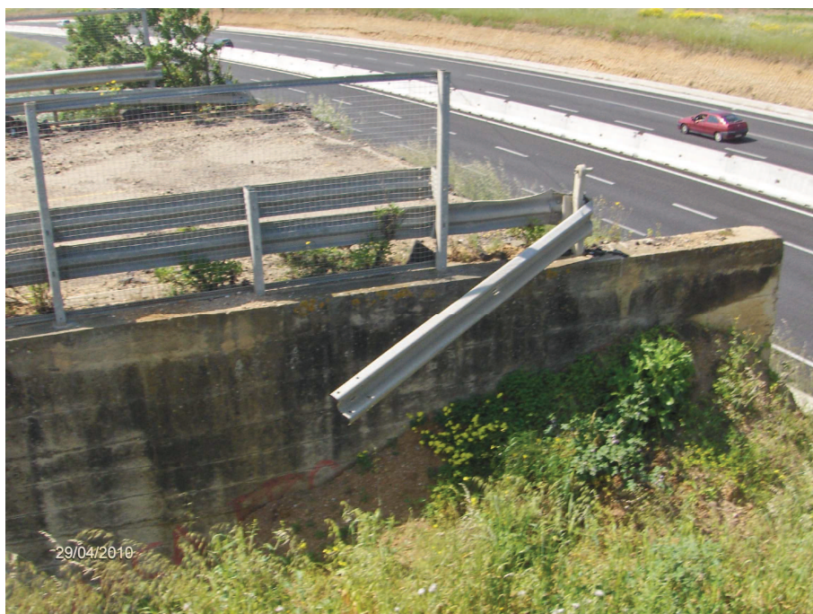
Foto n° 8.4 – Reliquato ex S.S. 131 "Oristano Nord" (posa recinzione metallica per chiusura cavalcavia dismesso)
