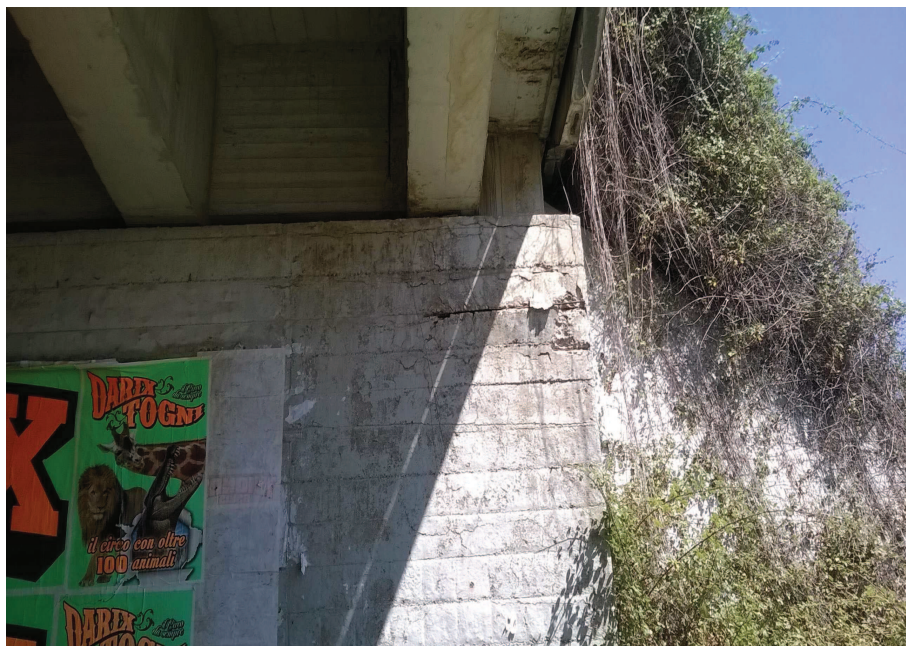
Foto n° 13.2 – Cavalcavia/ Cavalcaferrovia esistente (lato Simaxis) spalla Nord. Risanamento superficie spalla previa asportazione corticale e passivazione ferri, smontaggio canaletta metallica)
