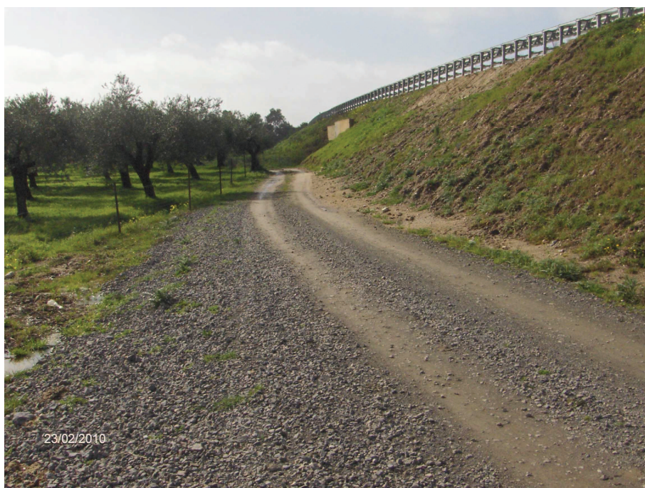
Foto n° 30.1 –Strada C e rilevato SS 131 (a dx) (bonifica, fondazione misto stabilizzato, cunette )
