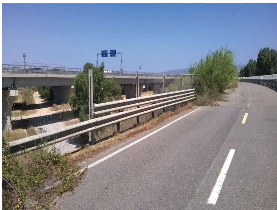
Foto n° 14.3 – Reliquato ex S.S. 131 (Zona 3) ( fresatura pavimentazione stradale, posa di terra vegetale e piantumazione, profilatura scarpata, rimozione barriere, paletti e rete antisasso (Int.1))
