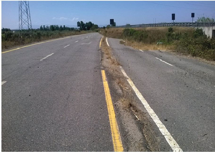
Foto n° 17.3 – Reliquato ex S.S. 131 (Zona 3 e 2) ( fresatura e demolizione pavimentazione stradale, posa di terra vegetale e piantumazione, profilatura scarpata)
