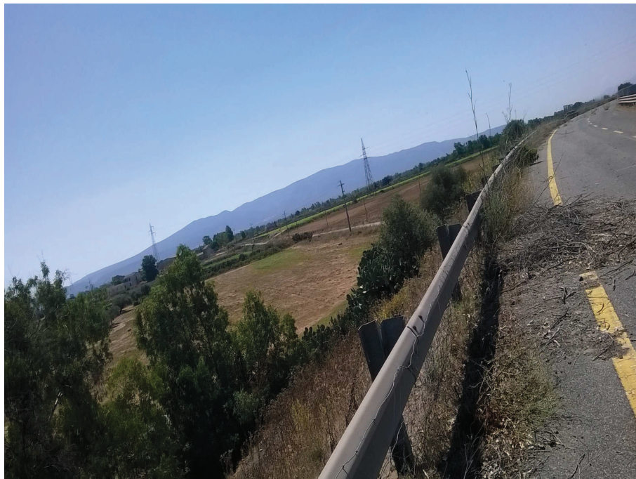
Foto n° 13.1 – Reliquato ex SS 131 (smontaggio barriera bordo laterale, ripasso segnaletica, smontaggio/montaggio barriera centrale, pulizia e sfalcio erba, smontaggio frangiluce)
