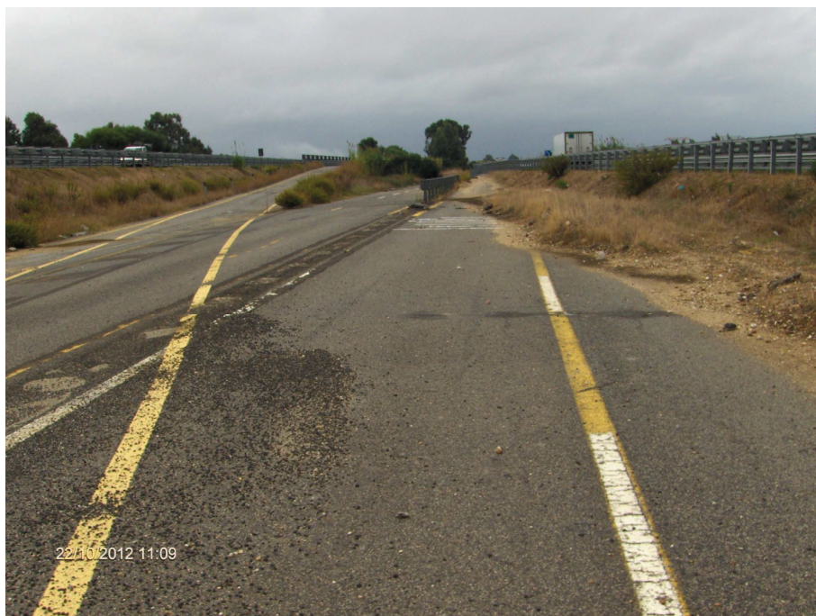
Foto n° 3.3 – Reliquato ex S.S. 131 (Zona 1) (fresatura pavimentazione stradale , posa in opera terreno vegetale e piantumazione)
