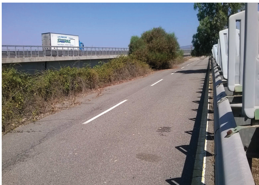
Foto n° 11.3 – Reliquato ex S.S. 131 (Zona 3) (rimozione barriere, fresatura pavimentazione stradale, posa di terra vegetale e piantumazione, profilatura scarpata, smontaggio rimontaggio barriera centrale e smontaggio frangiluce (Int.1) )
