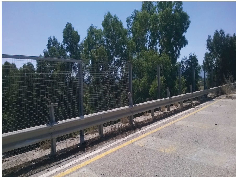
Foto n° 7.1 – Cavalcavia reliquato ex SS 131 (smontaggio barriera bordo ponte, taglio paletti non recuperabili, smontaggio rete parasassi, cancellazione segnaletica provvisoria)
