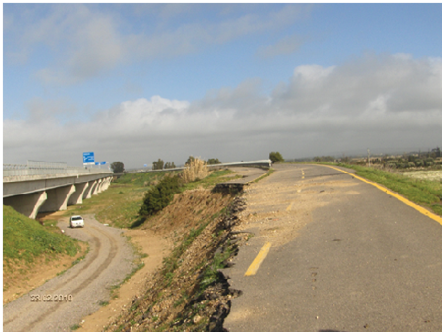
Foto n° 1.3 – Reliquato ex S.S. 131 e viadotto "Oristano" (demolizione e fresatura pavimentazione stradale, posa in opera terreno vegetale)
