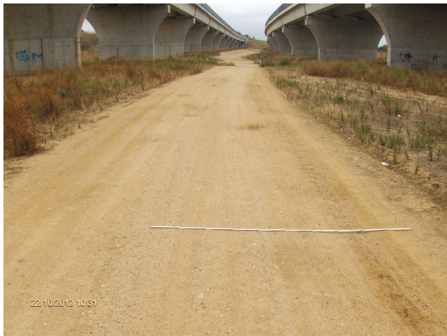
Foto n° 21.1 – Viabilità esistente da sistemare (Strada B) fra viadotto “Tirso” e Viadotto “Oristano” (bonifica, fondazione in misto stabilizzato, cunette)
