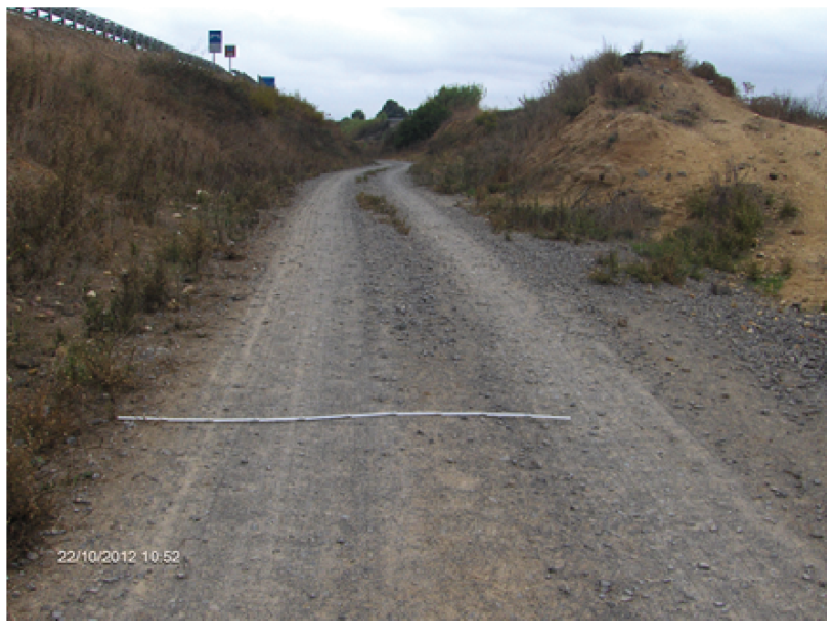
Foto n° 28.1 –Strada C, reliquato ex SS 131 (a dx) e rilevato SS 131 (a sx) (bonifica, fondazione misto stabilizzato, cunette, scavo reliquato zona 2 )
