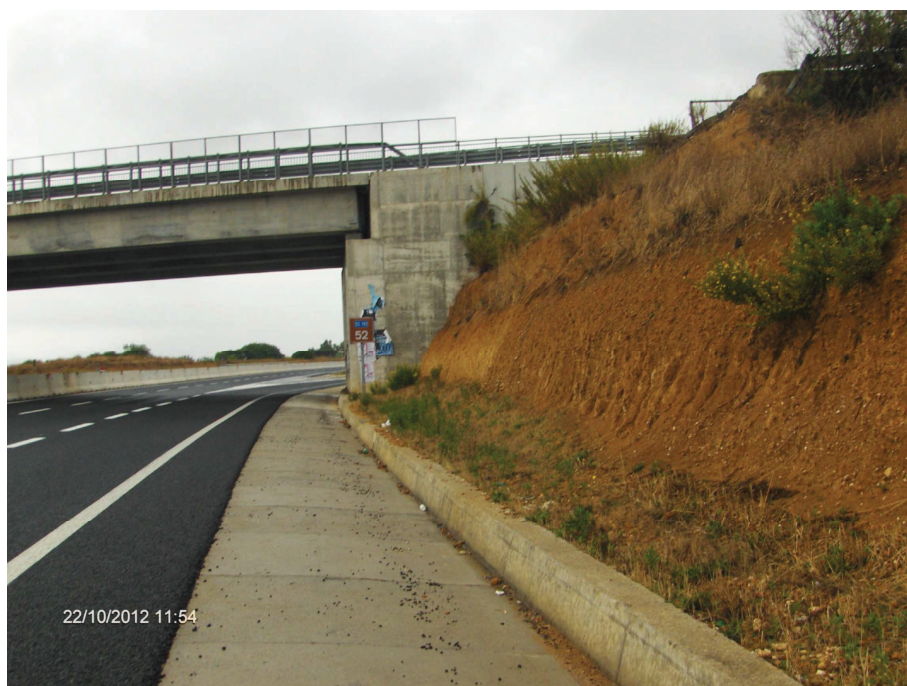
Foto n° 10.4 – S.S. 131 “Oristano Nord” (muretto in c.a su cunetta alla francese)
