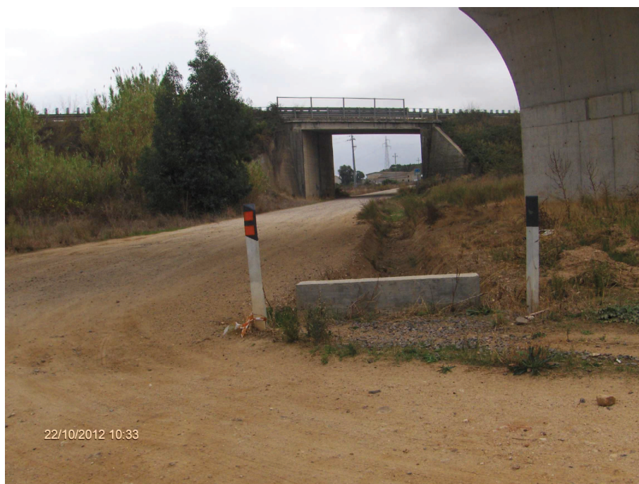
Foto n° 22.1 – Incrocio tra Viabilità da sistemare (Strada B) e viabilità comunale esistente (bonifica, fondazione in misto stabilizzato, cunette)
