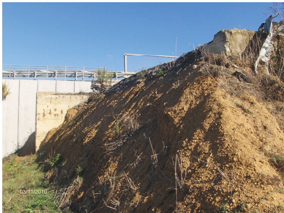
Foto n° 9.4 – Reliquato ex S.S. 131 “Oristano Nord” (posa recinzione metallica per chiusura cavalcavia dismesso)
