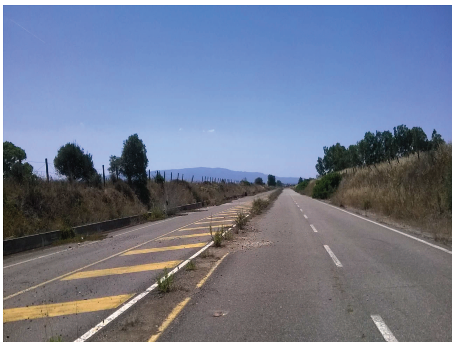
Foto n° 4.4 – Reliquato ex S.S. 131 "Oristano Nord" (fresatura pavimentazione stradale, cordona stradale, posa di terra vegetale e piantumazione)
