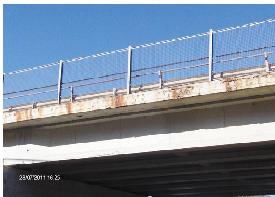
Foto n° 6.2 – Cavalcavia/ Cavalcaferrovia esistente (lato Oristano) Smontaggio rete parasassi , paletti e barriera bordo ponte, risanamento cordolo e intradosso impalcato, previa asportazione corticale e passivazione dei ferri (Int. 1)
