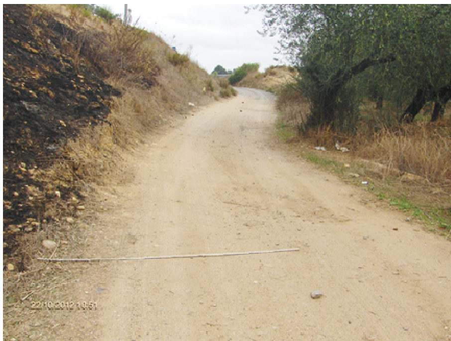
Foto n° 29.1 –Strada C, rilevato SS 131 (a sx) (bonifica, fondazione misto stabilizzato, cunette )
