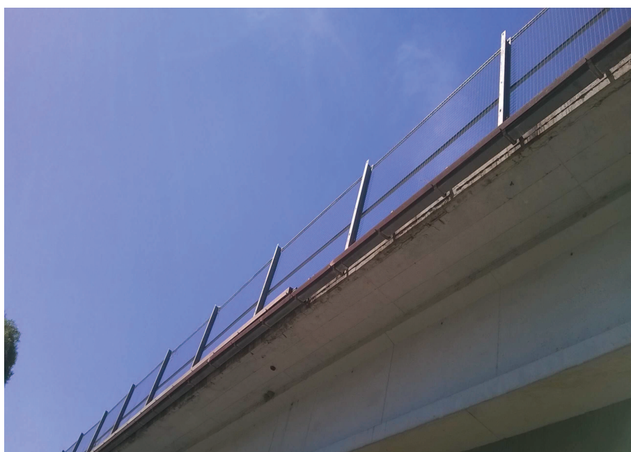
Foto n° 16.2 – Cavalcavia/ Cavalcaferrovia esistente (lato Simaxis). Smontaggio canaletta metallica, rete parasassi, paletti e barriera bordo ponte (Int.1). Risanamento intradosso impalcato previa asportazione corticale e passivazione ferri.
