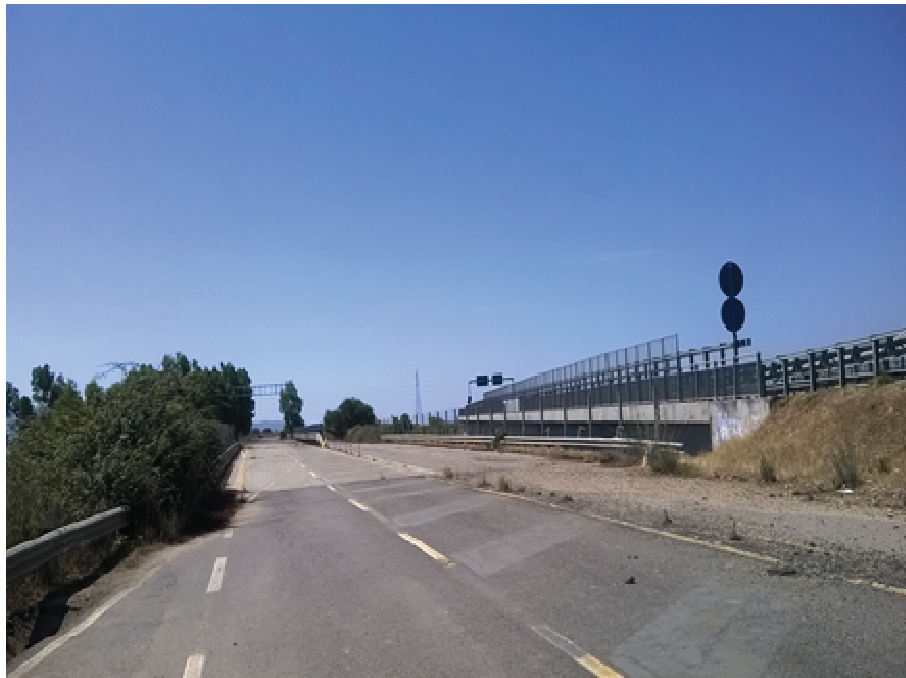
Foto n° 6.1 – Attacco Rampa Strada A con cavalcavia e reliquato ex SS 131 (smontaggio barriere bordo ponte, taglio paletti di sostegno, smontaggio rete parasassi)
