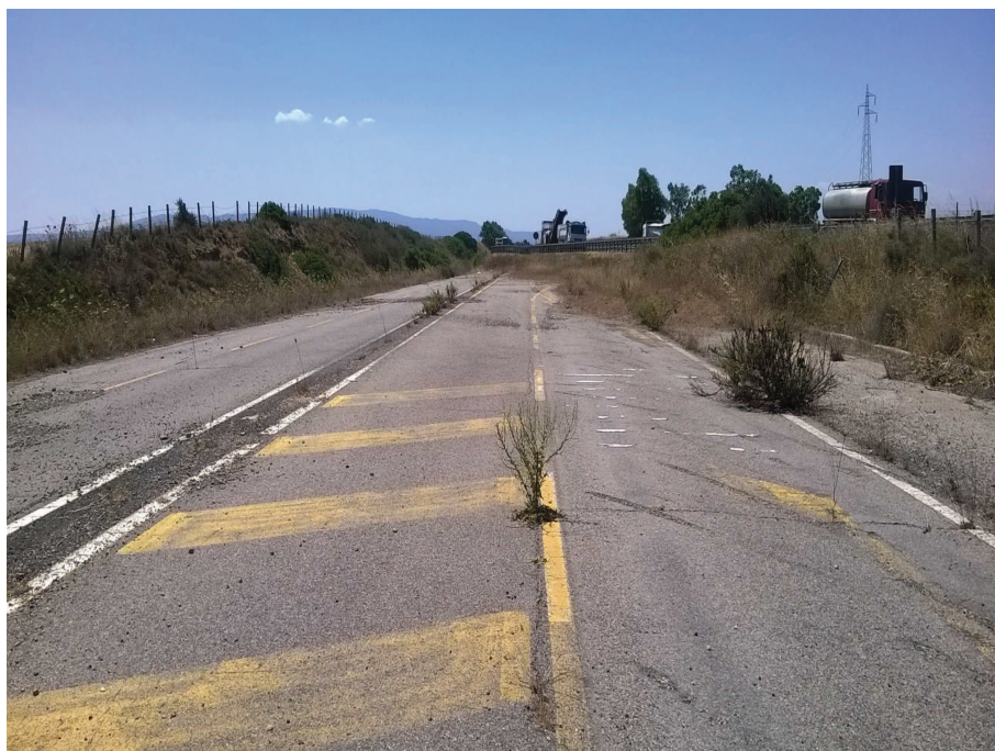
Foto n° 3.4 – Reliquato ex S.S. 131 "Oristano Nord" (fresatura pavimentazione stradale, cordona stradale, posa di terra vegetale e piantumazione)
