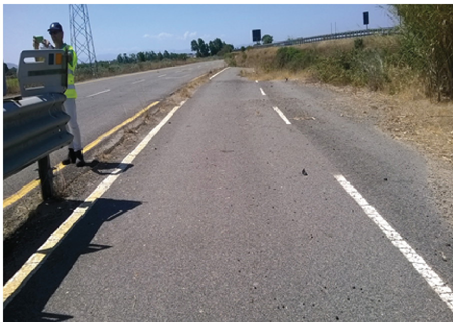
Foto n° 16.3 – Reliquato ex S.S. 131 (Zona 3 e 2) ( fresatura e demolizione pavimentazione stradale, posa di terra vegetale e piantumazione, profilatura scarpata, smontaggio/rimontaggio barriera centrale e smontaggio frangiluce (Int.1))
