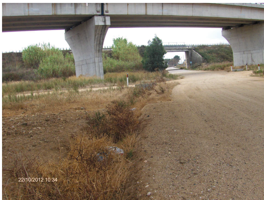
Foto n° 23.1 – Incrocio tra Viabilità da sistemare (Strada B) e viabilità comunale esistente (bonifica, fondazione in misto stabilizzato, cunette)
