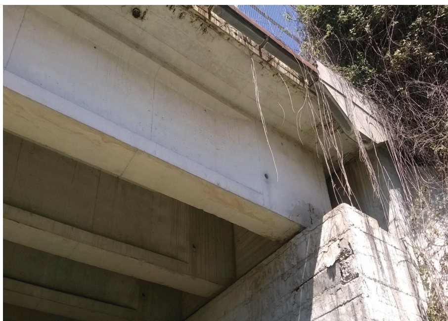
Foto n° 14.2 – Cavalcavia/ Cavalcaferrovia esistente (lato Simaxis) spalla Nord. Risanamento superficie spalla e intradosso impalcato previa asportazione corticale e passivazione ferri, smontaggio canaletta metallica)
