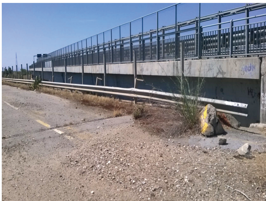
Foto n° 8.3 – Reliquato ex S.S. 131 su cavalcaferrovia e viadotto "Oristano" ( rimozione barriere, paletti e rete antisasso)
