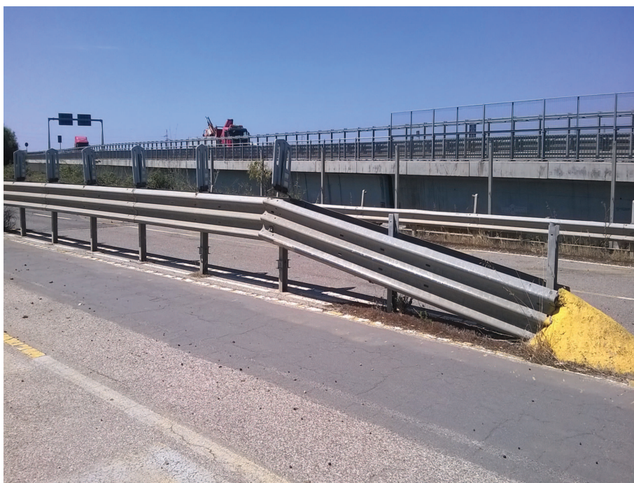
Foto n° 8.1 – Cavalcavia reliquato ex SS 131 (smontaggio barriera bordo ponte, taglio paletti non recuperabili, smontaggio rete parasassi, smontaggio/rimontaggio barriera centrale, smontaggio frangiluce)
