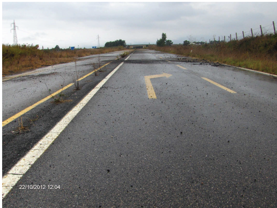
Foto n° 1.4 – Reliquato ex S.S. 131 "Oristano Nord" (fresatura pavimentazione stradale, cordona stradale, posa di terra vegetale e piantumazione)
