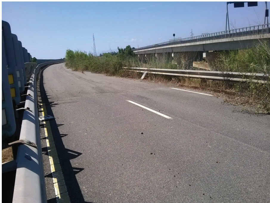
Foto n° 9.3 – Reliquato ex S.S. 131 (Zona 3) (rimozione barriere, fresatura pavimentazione stradale, posa di terra vegetale e piantumazione, profilatura scarpata, smontaggio rimontaggio barriera centrale e smontaggio frangiluce)
