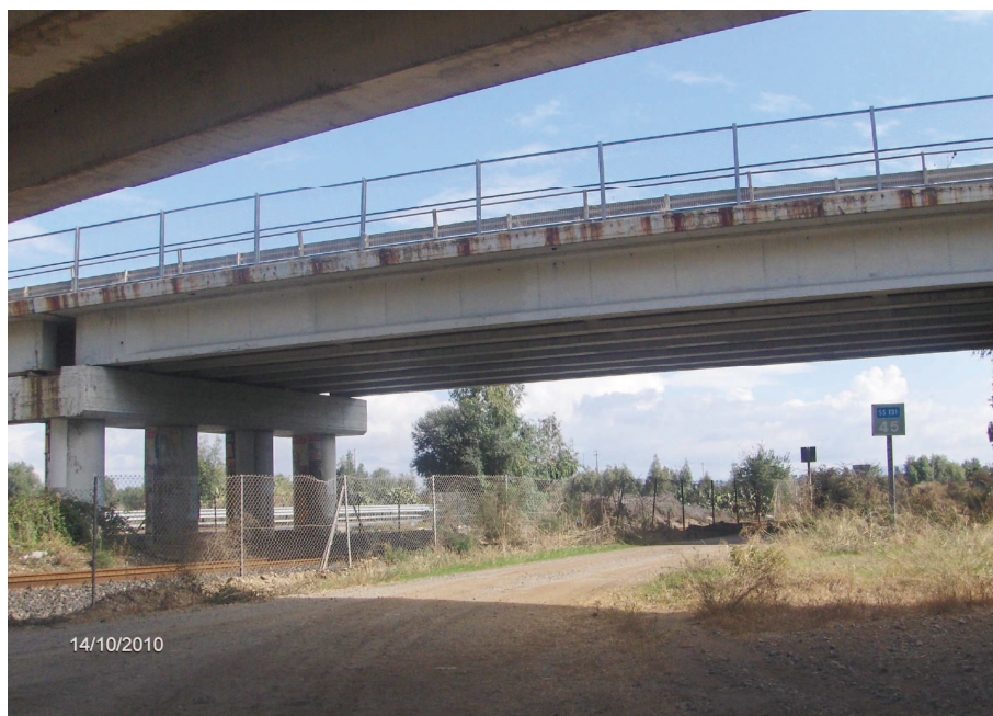
Foto n° 11.2 – Cavalcavia/ Cavalcaferrovia esistente (lato Oristano). Smontaggio rete parasassi, paletti e barriera bordo ponte (Int. 1). Risanamento cordolo e pulvino pila centrale, previa asportazione corticale e passivazione ferri.
