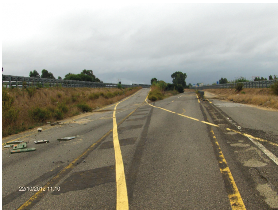
Foto n° 4.3 – Reliquato ex S.S. 131 (Zona 1) (fresatura pavimentazione stradale, posa in opera terreno vegetale e piantumazione)
