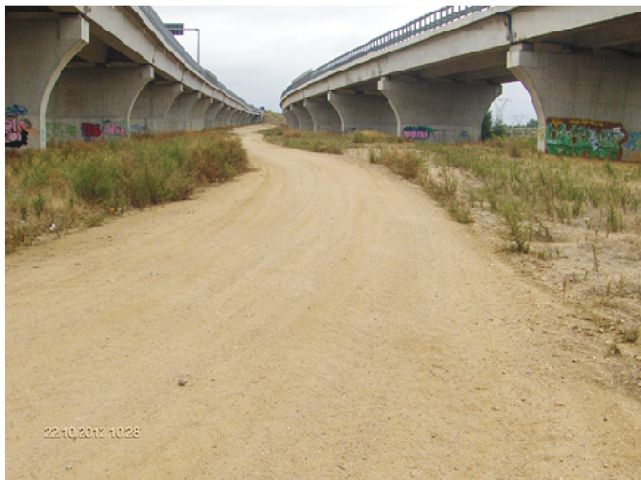
Foto n° 19.1 – Viabilità esistente da sistemare (Strada B) fra viadotto “Tirso” e Viadotto “Oristano” (bonifica, fondazione in misto stabilizzato, cunette)
