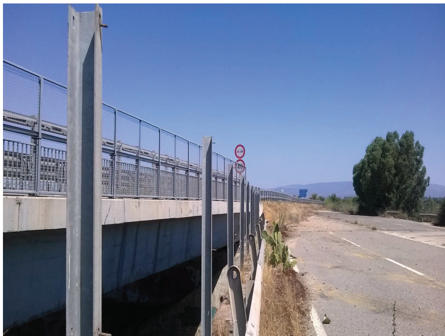
Foto n° 7.3 – Reliquato ex S.S. 131 su cavalcaferrovia ( rimozione barriere, paletti e rete antisasso)
