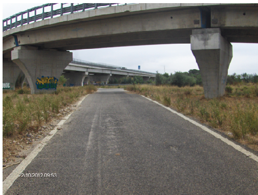
Foto n° 20.1 – Viabilità esistente c/o svincolo di Sili sotto rampa Sassari- Oristano
