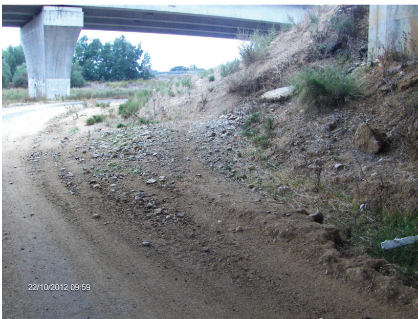
Foto n° 2.1 – Viabilità esistente c/o spalla Nord cavalcavia Silì (muretto in c.a. per protezione strada, posa in opera embrici per smaltimento acqua di piattaforma)
