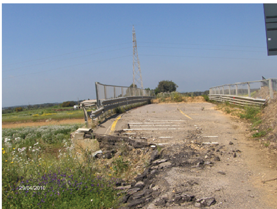
Foto n° 6.4 – Reliquato ex S.S. 131 “Oristano Nord” (posa recinzione metallica per chiusura cavalcavia dismesso)
