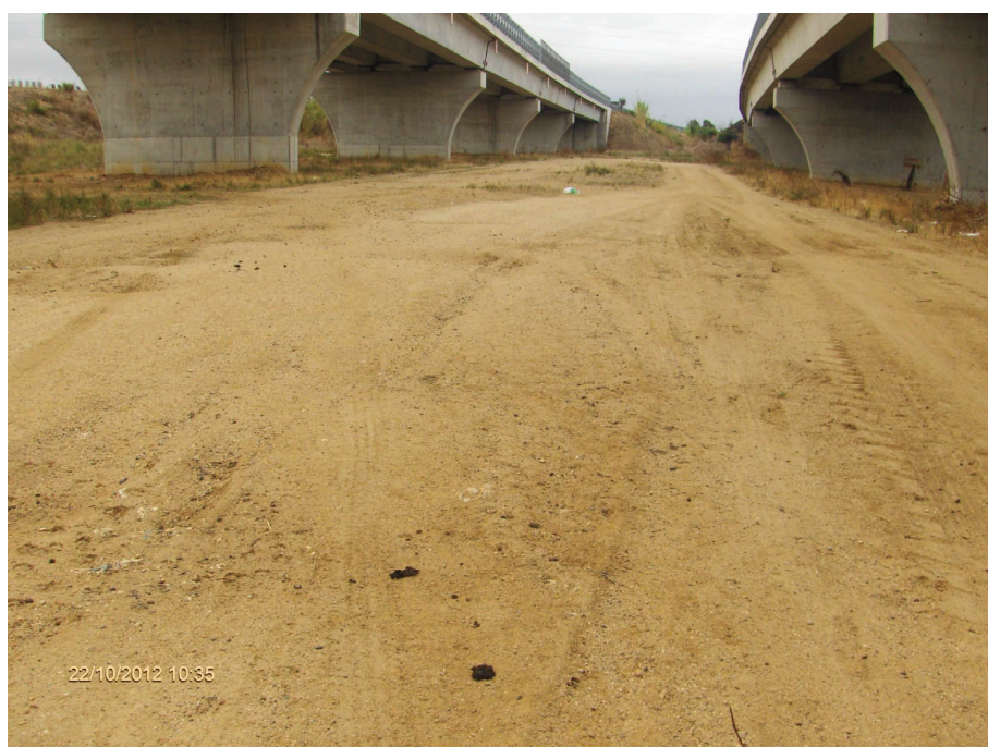
Foto n° 24.1 – Viabilità esistente da sistemare (Strada B) fra viadotto "Tirso" e Viadotto "Oristano" (bonifica, fondazione in misto stabilizzato, cunette)
