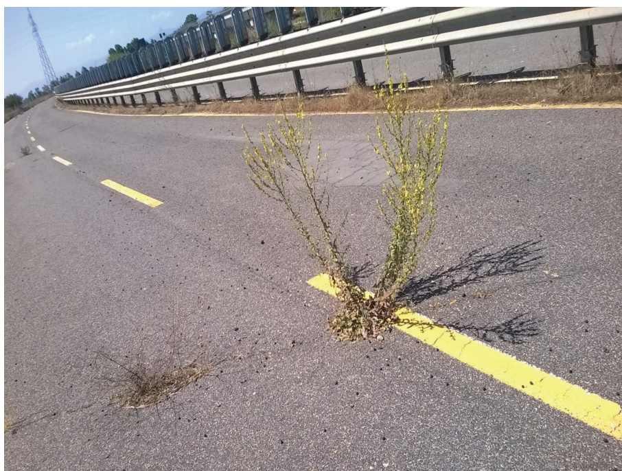
Foto n° 16.1 – Reliquato ex SS 131 pressi sottopasso (cancellazione segnaletica, smontaggio/montaggio barriera centrale, sfalcio erba, smontaggio frangiluce, riparazione buche pavimentazione)
