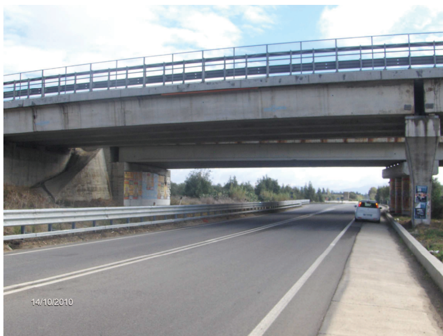
Foto n° 8.2 – Cavalcavia/ Cavalcaferrovia esistente in secondo piano lato Oristano) Spalla Nord e pulvino pila centrale
