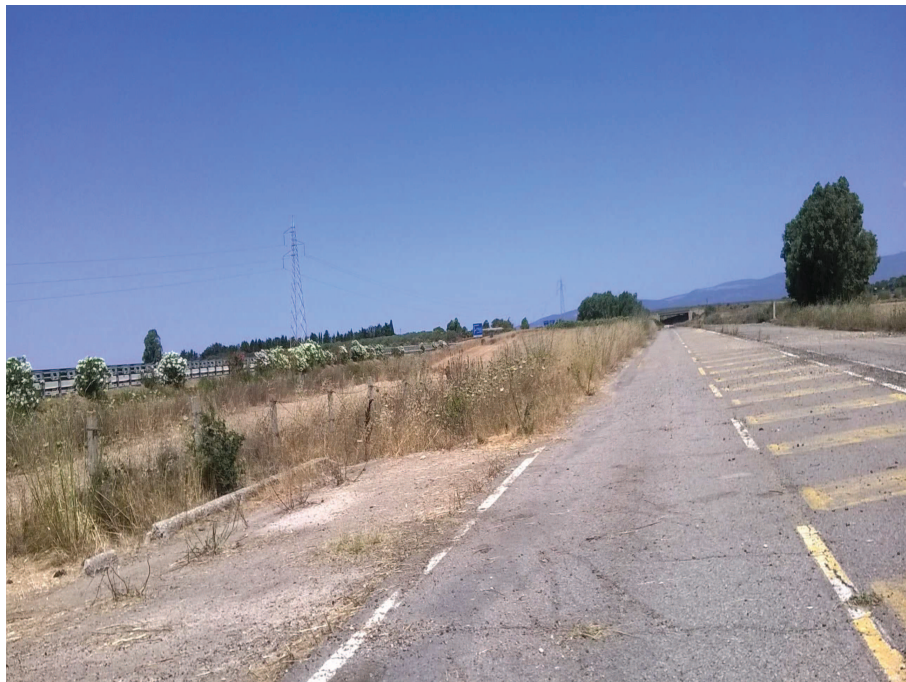
Foto n° 5.4 – Reliquato ex S.S. 131 “Oristano Nord” (fresatura pavimentazione stradale, cordona stradale, posa di terra vegetale e piantumazione)
