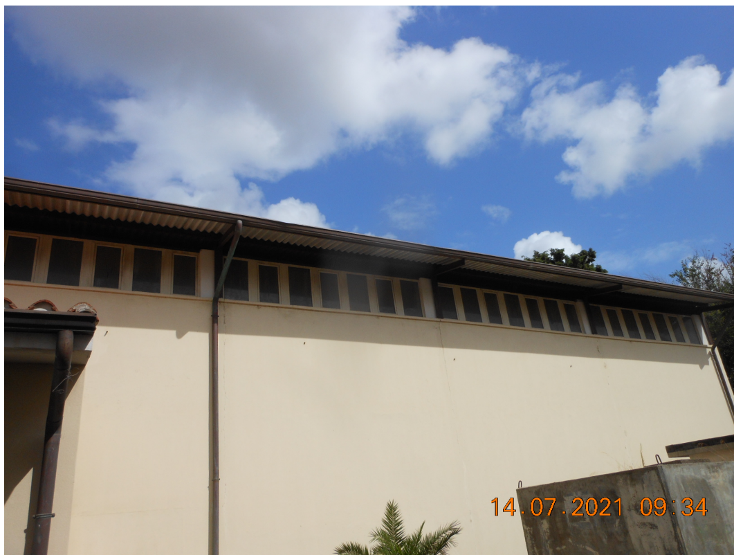
Esterno prospetto est
