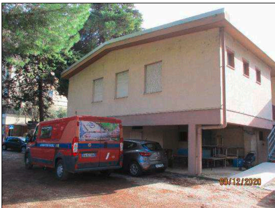
FOTO 2, VISTA LATERALE DELL'EDIFICIO
