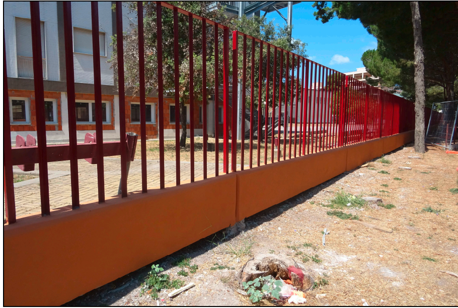
FOTO 3, RECINZIONE LATO SCUOLE MAGISTRALI RECENTEMENTE SISTEMATA
