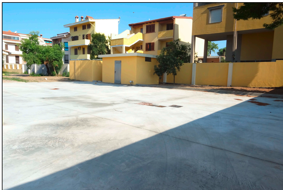
FOTO 6 , VISTA DEL PIAZZALE DI ACCESSO E DEI VANI TECNICI ANTINCENDIO
