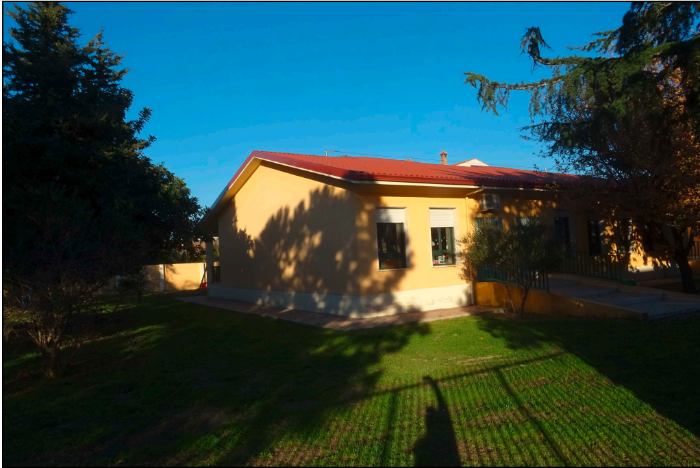
FOTO 1 , VISTA LATERALE EDIFICIO SCOLASTICO
