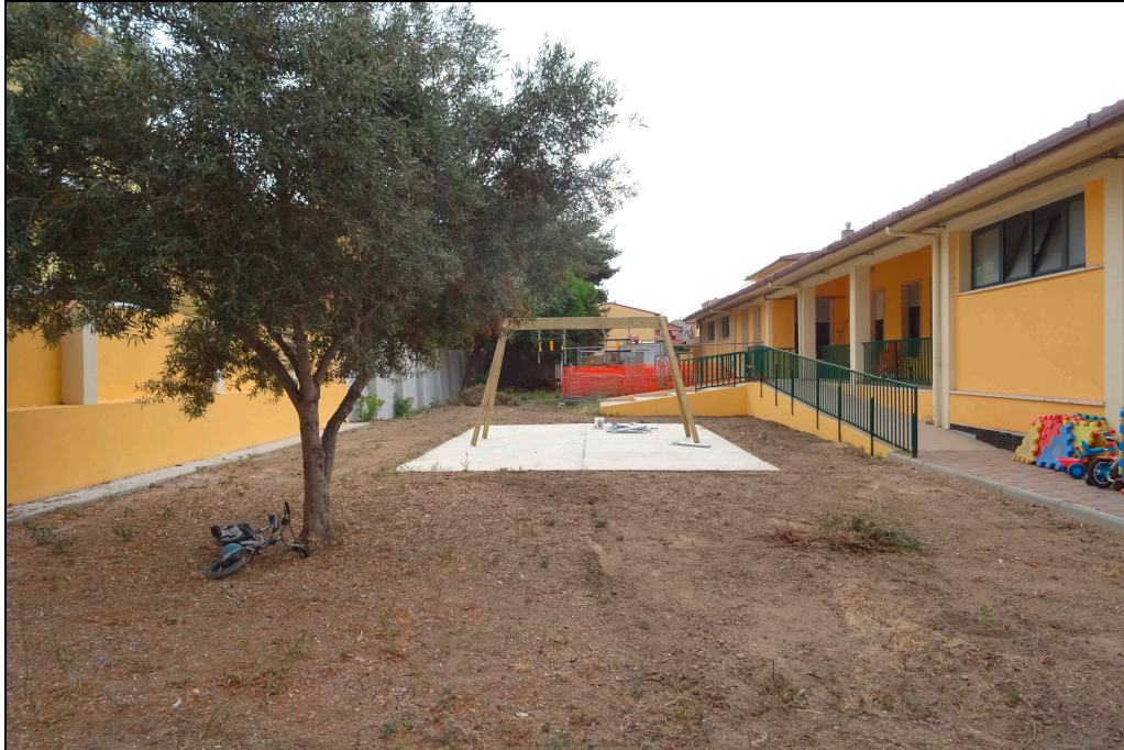
FOTO 3 , PROSPETTO POSTERIORE - AREA GIOCHI ESTERNA DURANTE I LAVORI DI SISTEMAZIONE
