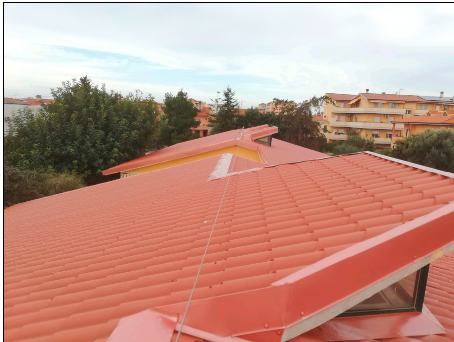
FOTO 5 , VISTA COMPLESSIVA NUOVO MANTO DI COPERTURA
