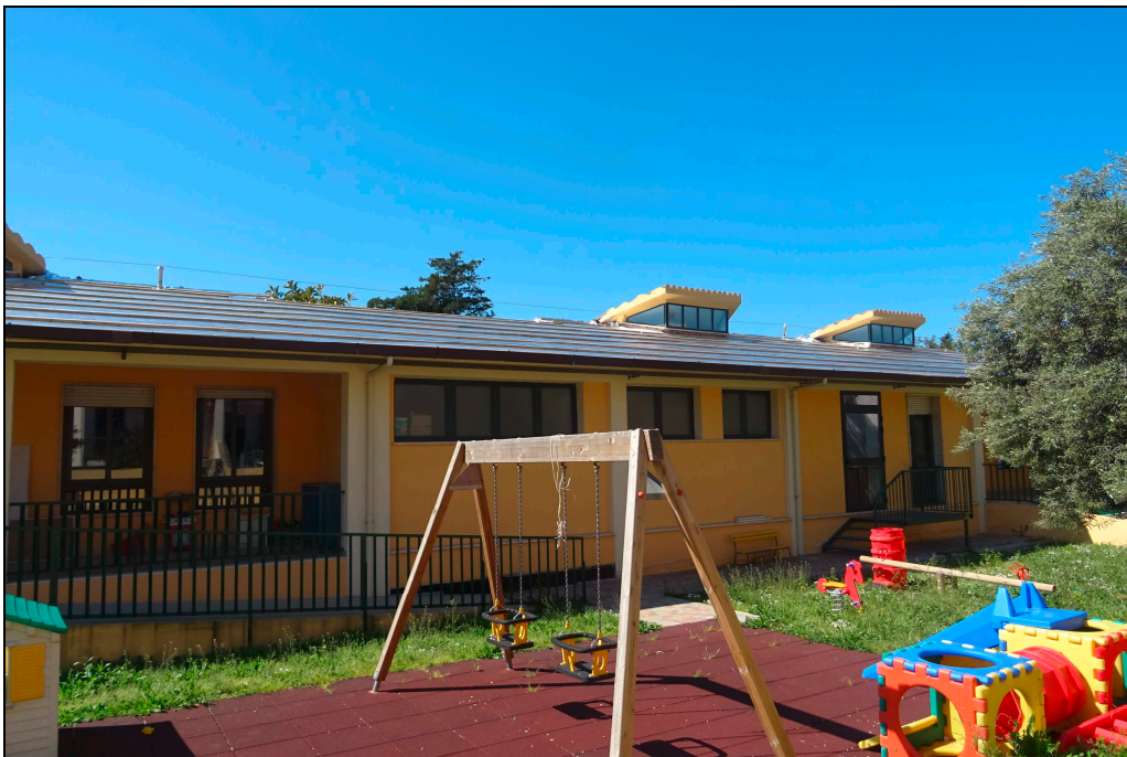
FOTO 4 , PROSPETTO POSTERIORE - DURANTE I LAVORI DI REALIZZAZIONE DEL NUOVO MANTO DI COPERTURA
