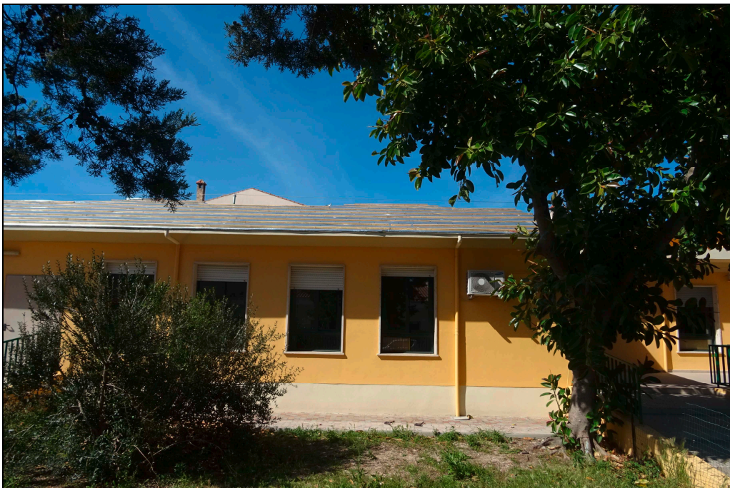
FOTO 2 , VISTA FRONTALE DELL'EDIFICIO DURANTE I LAVORI DI REALIZZAZIONE DEL NUOVO MANTO DI COPERTURA
