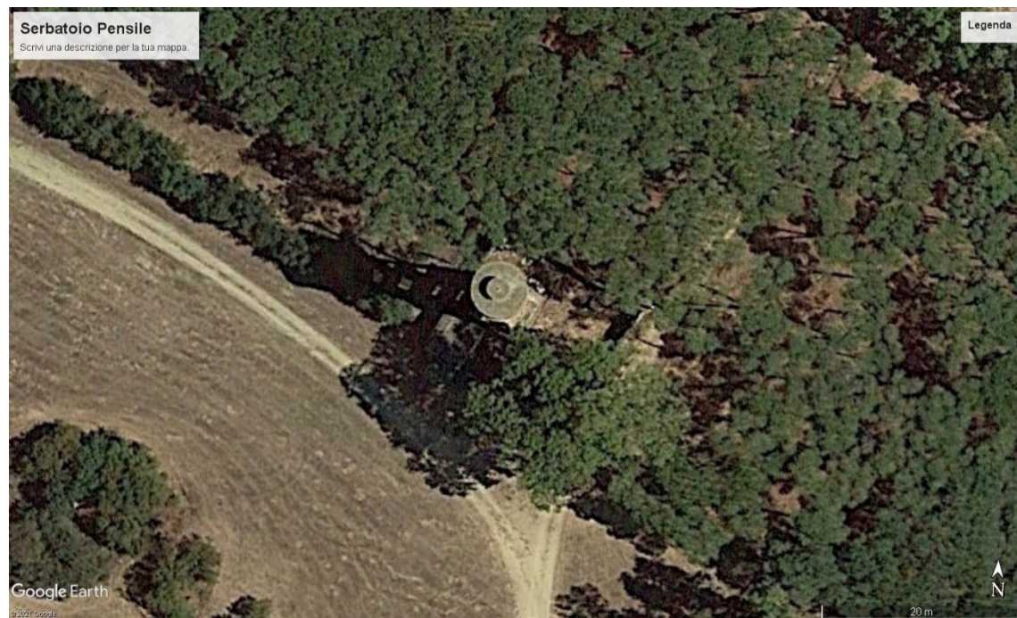
Figura 2 Vista dall'alto del serbatoio
