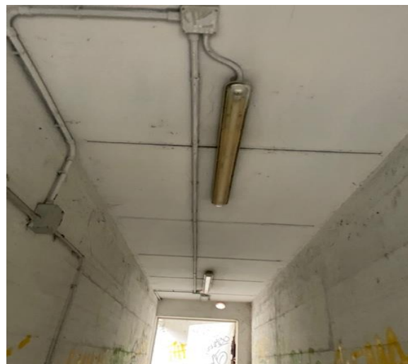
Foto n. 3 - Via di uscita Via Verdi
