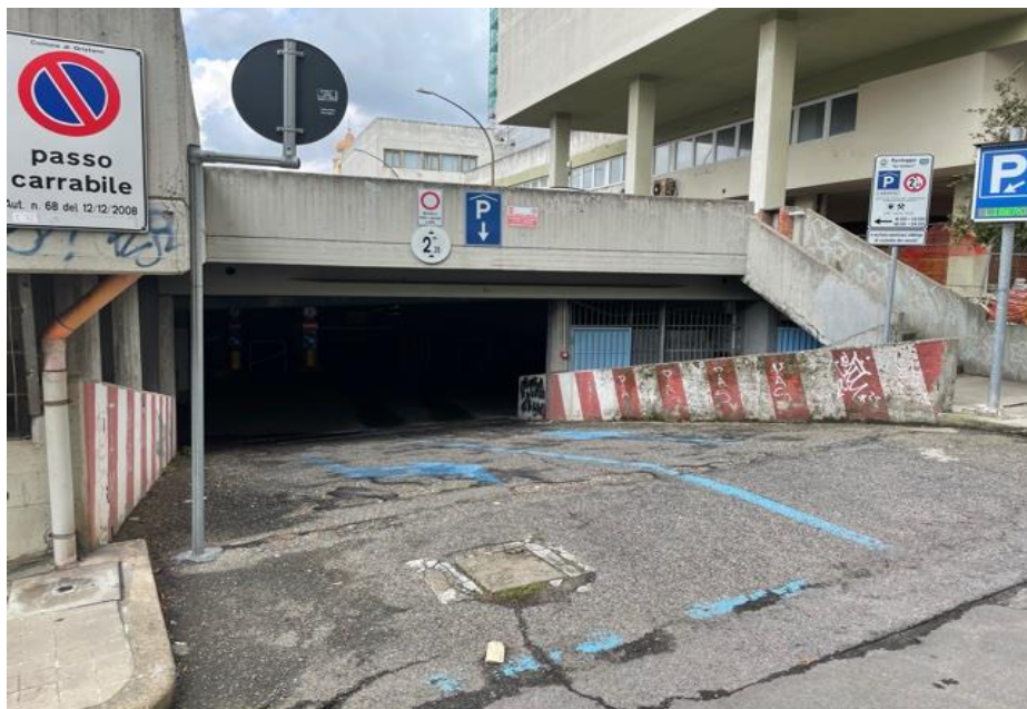
Foto n. 6 - Ingresso carrabile Via Carducci
