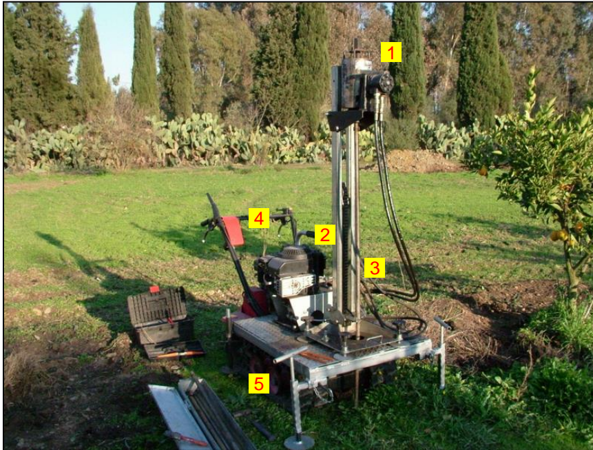
Fig. 5 - Fotografia dello strumento utilizzato montato su mezzo semovente:
