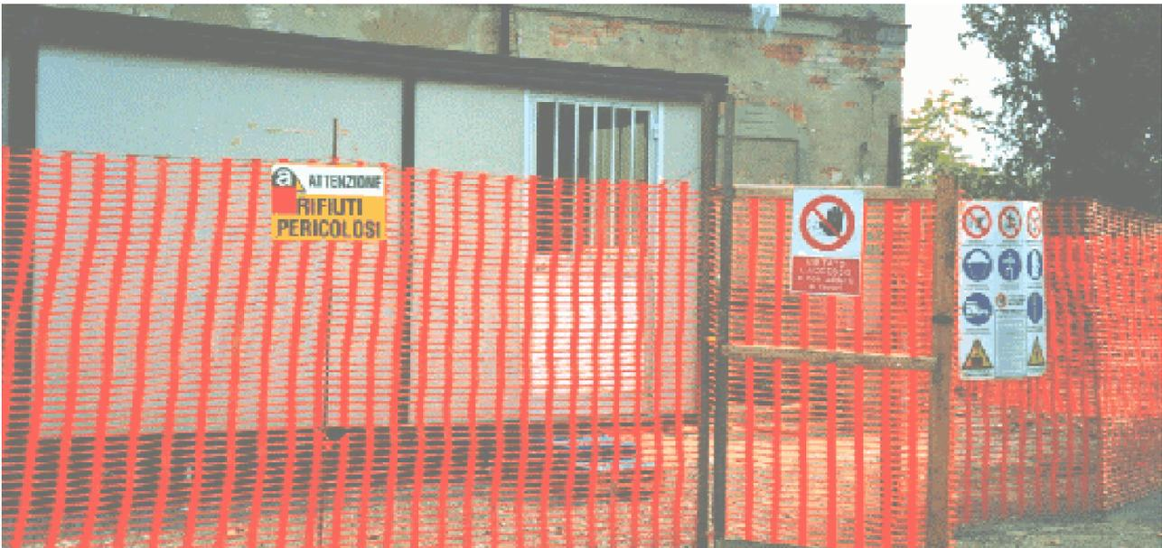
Le operazioni di rimozione delle lastre di cemento amianto possono comportare la liberazione di fibre di amianto e pertanto le aree di cantiere devono essere interdette al personale non autorizzato, delimitandole, e il pericolo va segnalato con una apposita cartellonistica, evitando peraltro frasi terrorizzanti. Nelle aree di cantiere devono potervi accedere solo i lavoratori addetti dopo aver indossato i mezzi di protezione individuale.
