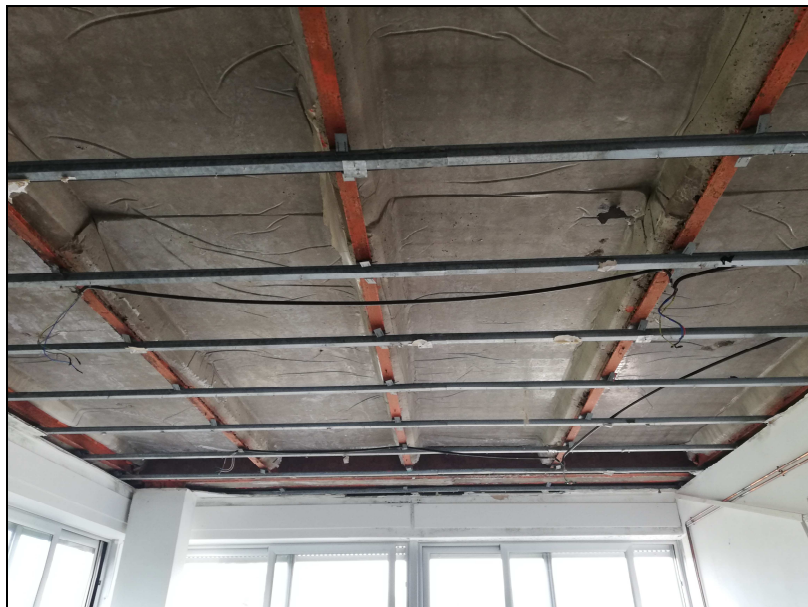
Figura 6 - Rimozione del controsoffitto ammalorato
